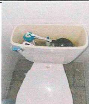
Foto 31: Sustrucción de accesorios para inodores 2/3 sanitario de niños, módulo 2
