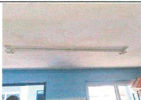
Foto 41: Sustitución de lámpara tipo LED: Sustitución de lámpara completa doble tubo en cocina, modulo 2
