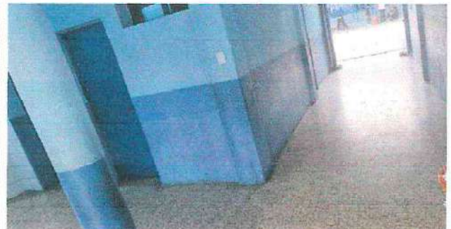
Foto 22: Pintura muros exteriores: Pintura de zócalo paredes exteriores módulo 2
