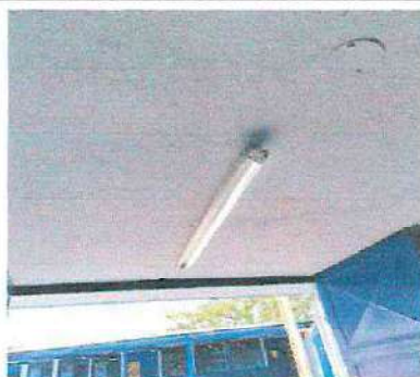
Foto 37: Sustitución de lámpara tipo LED: Sustitución de tubo LED, 1 tubo de pasillo entrada
