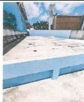
Foto 2: Impermeabilización losa 2/6, pasillo 2, módulo 2
