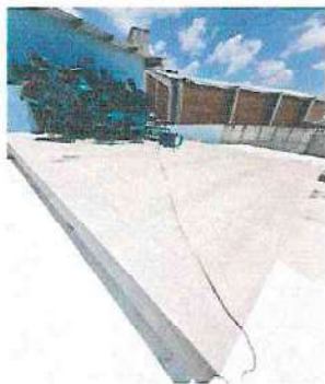
Foto1: Impermeabilización de losa 1/6, pasillo 1, módulo 2
