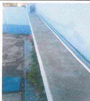
Foto 11: Reparación de pañuelos: Refuerzo de cenefa con sikatela, e impermeabilización, en frente de las direcciones, módulo 2
