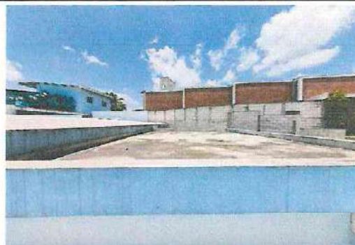
Foto 4: Impermeabilización de losa 4/6 pasillo 3 módulo 2
