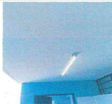
Foto 38: Sustitución de lámpara tipo LED: Sustitución de tubo LED, 2 tubos de pasillo sanitarios
