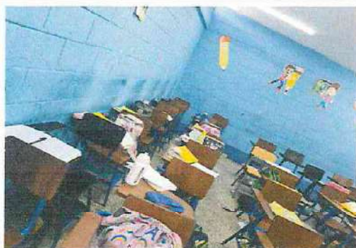
Foto 15: Pintura muros interiores: Pintura a 2 colores muros interiores salón de 4to "A", módulo 2
