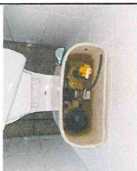
Foto 29: Sustitución de accesorios para inodores 1/3 sanitario de niñas, módulo 2
