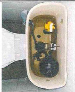
Foto 27: Sustitución de accesorios para inodores 1/3 sanitario de niñas, módulo 2
