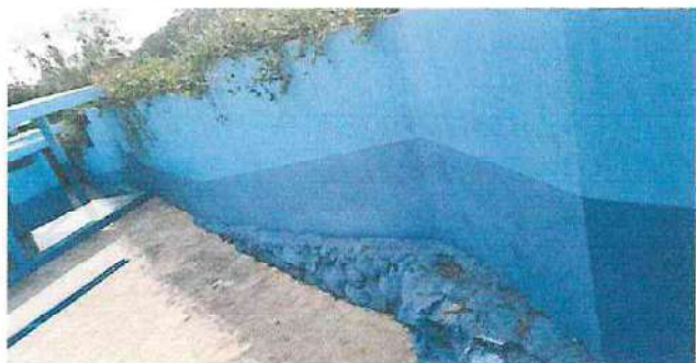
Foto 25: Pintura de zócalo paredes exteriores módulo 2
