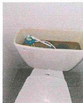
Foto 32: Sustrucción de accesorios para inodores 3/3 sanitario de niños, módulo 2
