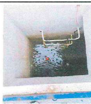
Foto 42: Mantenimiento Cisterna: Limpieza, pintura y corte de escalones de metal en cisterna patio módulo 2
