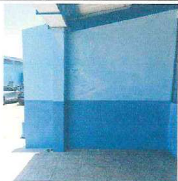
Foto 7: Impermeabilización: Frente de la pared de 3ero "A" que se impermeabilizará por la parte de atrás, módulo 1
