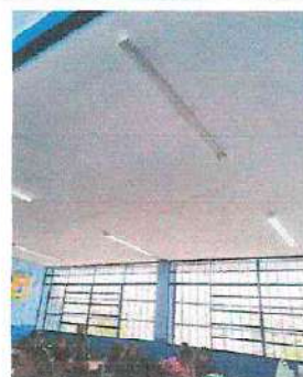
Foto 40: Sustitución de lámpara tipo LED: Sustitución de tubo LED, 2 tubos en salón de 1ero "A", módulo 2
