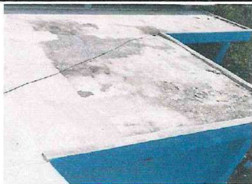
Foto 13: Impermeabilización de losa: Resanar alrededor de 1 bajada de agua en una plataforma de losa impermeabilizar área, en módulo 2
