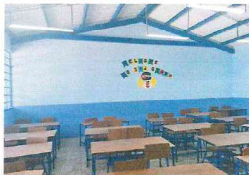
Foto 8: Impermeabilización: Interior de salón de 3era "A" que se impermeabilizará por la parte de atrás, módulo 1
