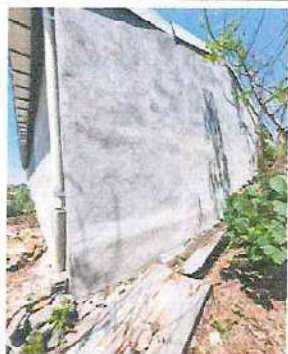
Foto 9: Impermeabilización: Pared, parte externa de salón de 3ero "A", módulo 1
