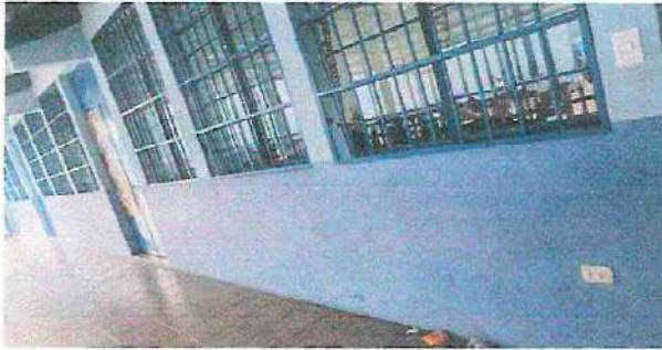
Foto 19: Pintura muros exteriores: Pintura de zócalo en paredes exteriores módulo 1
