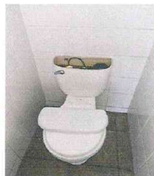
Foto 28: Sustitución de accesorios para inodores 1/3 sanitario de niñas, módulo 2
