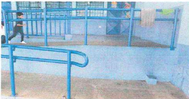
Foto 21: Pintura muros exteriores: Pintura de zócalo paredes exteriores módulo 1
