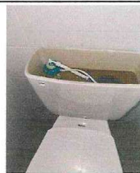
Foto 30: Sustitución de accesorios para inodores 1/3 sanitario de niños, módulo 2
