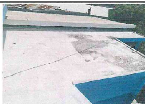
Foto 6: Impermeabilización de losa 6/6 pasillo 3 módulo 2
