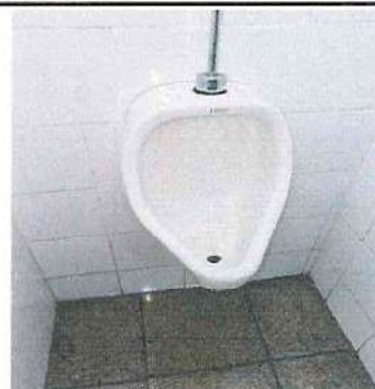
Foto 26: Servicios sanitarios: Desmontaje, reparación e instalación de mingitorio en sanitario para varones, módulo 2
