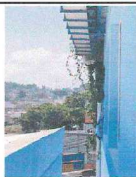
Foto 34: Muro perimetral: Limpieza y mantenimiento de canal corte de hiedra en pared que va hacia el canal aula 2do nivel módulo 2
