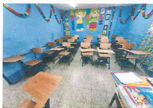
Foto 16: Pintura muros interiores: Pintura a 2 colores muros interiores salón de 4to. "B", módulo 2
