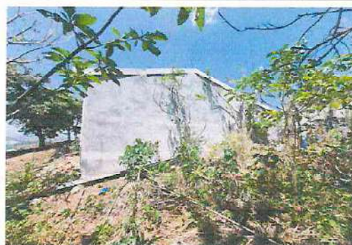
Foto 10: Impermeabilización: Exterior salón 3ero "A", impermeabilización de pared, módulo 1
