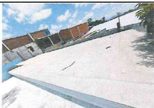
Foto 5: Impermeabilización de losa 5/6 pasillo 3 módulo 2
