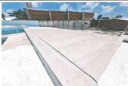
Foto 3: Impermeabilización de losa 3/6 pasillo 2, módulo 2
