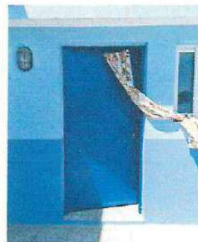
Foto 14: Puerta de metal: Desmontar puerta darle vuelta para que tenga apertura hacia afuera, salón preparatoria módulo 2
