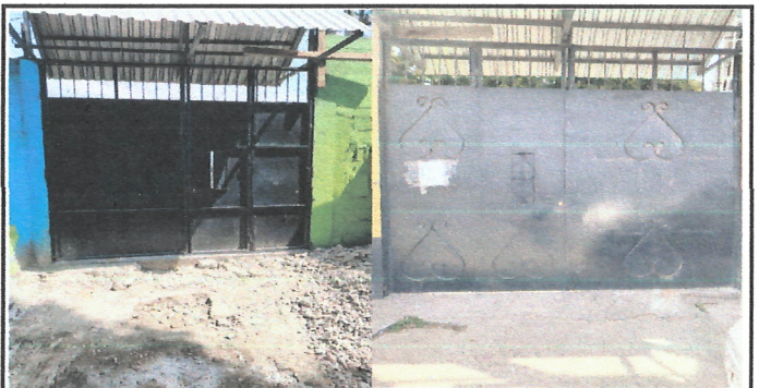
Foto 6 Mantenimiento a porton de metal
