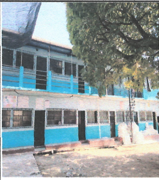
Foto 3 Mantenimiento de balcones de metal
