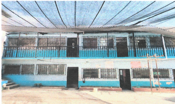
Foto 5 Mantenimiento a barandas de metal
