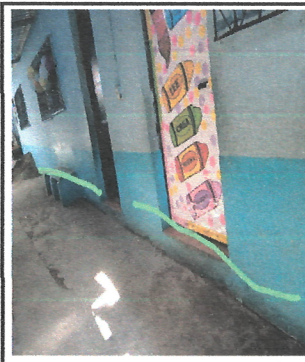
FOTO 4 Pintura en muros exteriores y socalo
