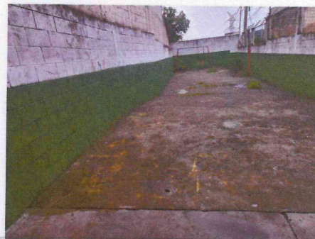
Foto 6: SUSTITUCION DE TORTA DE CONCRETO POR TORTA DE CONCRETO DE 10 CM CON ELECTROMAYA
