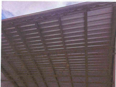
Foto1: SUSTITUCION DE LAMINA POR LAMINA TROQUELADA ALUZINNC CALIBRE 26
