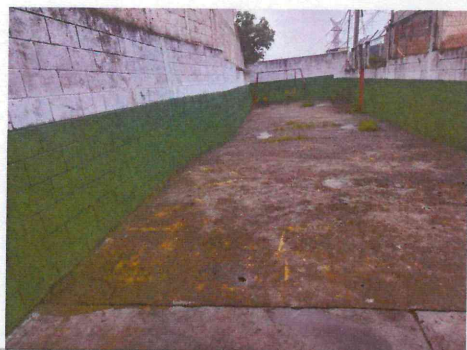
Foto 3: SUSTITUCION DE TORTA DE CONCRETO POR TORTA DE CONCRETO DE 10 CM CON ELECTROMAYA
