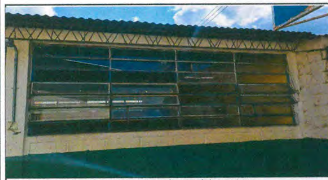
Foto 5: Mantenimiento a estructura de metal de ventana.
