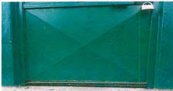
FOTO 11: Reparacion de parte baja de puertas ( requiere cortado de tubo y reforzado con hembra medida de 1 pulga ancho x 1 1/2 de alto y 1 metro de largo)
