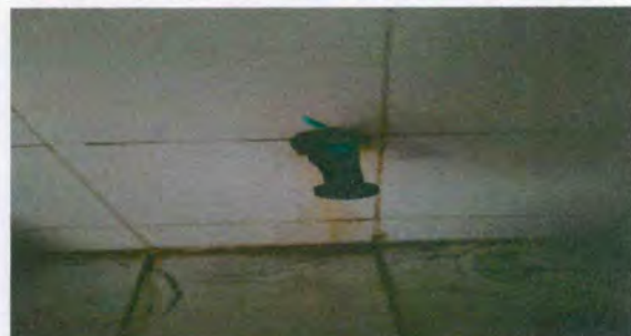
FOTO 12 sustitucion de chorros 1/2
