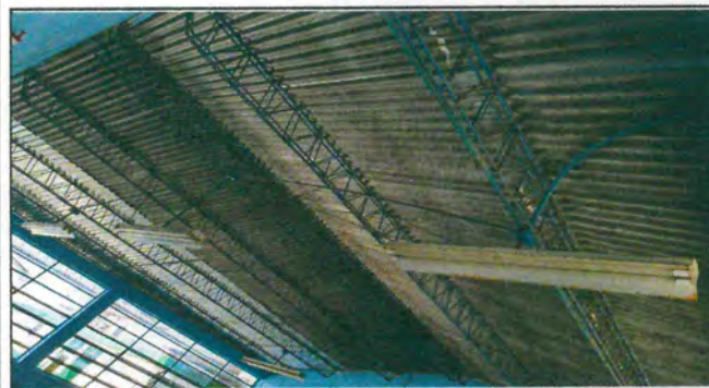
Foto 3: Remosamiento de estructuras Tipo jois incluye lijado y aplicación de pintura anticorrosiva color azul.
