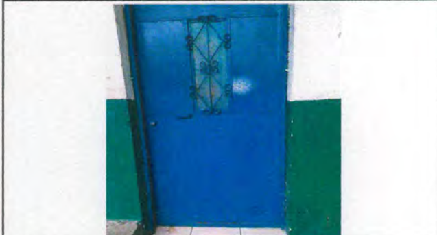
FOTO 10: Remozamiento de puertas incluye lijado y aplicación de pintura.
