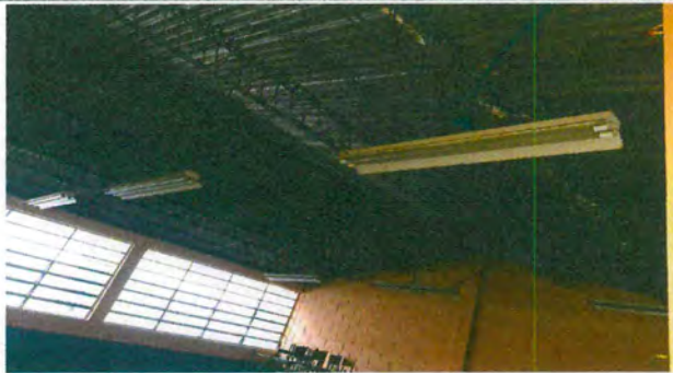
Foto 7 : Sustitución de lamparas
