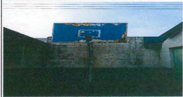
Foto 8: Remozamiento de estructura metalica de los tableros de las canchas de basquetboll.
