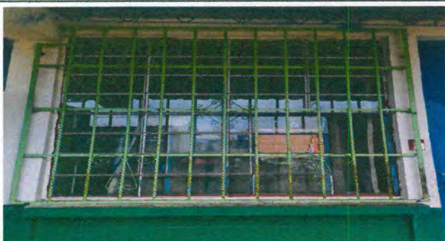
FOTO 9: Mantenimiento a blacon
