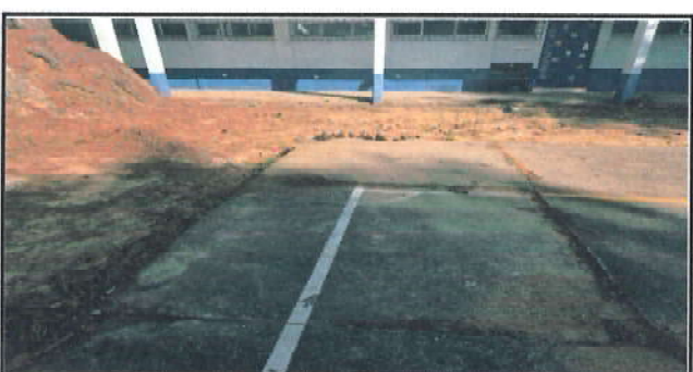
Foto 6: planchas craqueladas inestables y riesgo para el estudiante
