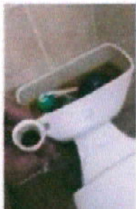
Foto 5: DEBIDO A LA CONTAMINACIÓN DEL AGUA EN LA CISTERNA, CON LODO Y PIEDRAS, SE PROVOCÓ DAÑO EN LOS ACCESORIOS DE SANITARIOS
