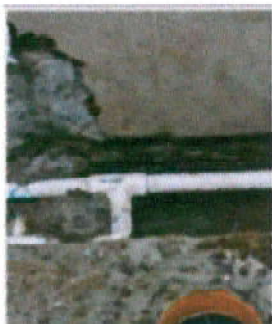
Foto 1: SUSTITUCION DE TUBERIA DE AGUA POTABLE
