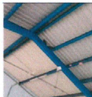
Foto 4: SELLADO DE ESPACIOS EN LA CUBIERTA PARA EVITAR INGRESO DE PALOMAS
