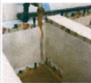
Foto 5: DEBIDO A LA CONTAMINACIÓN DEL AGUA EN LA CISTERNA, CON LODO Y PIEDRAS, SE PROVOCÓ DAÑO EN LOS ACCESORIOS DE SANITARIOS
