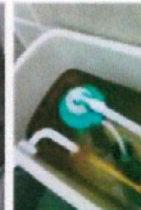
Foto 6: ES NECESARIA LA SUSTITUCIÓN DE LAS MANGERAS DE ABASTO DE INODOROS DEBIDO A LOS DAÑOS PROVOCADOS POR EL AGUA CONTAMINADA CON RESIDUOS
