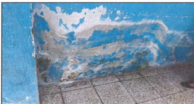
FOTO 5: REPARACION DE FILTRACION DE AGUA EN COCINA
