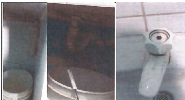
FOTO 6: SUSTITUCION DE GRIFOS Y CESPOL
