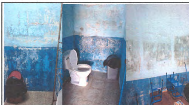
FOTO 3: IMPERMEABILIZACION DE MUROS,
