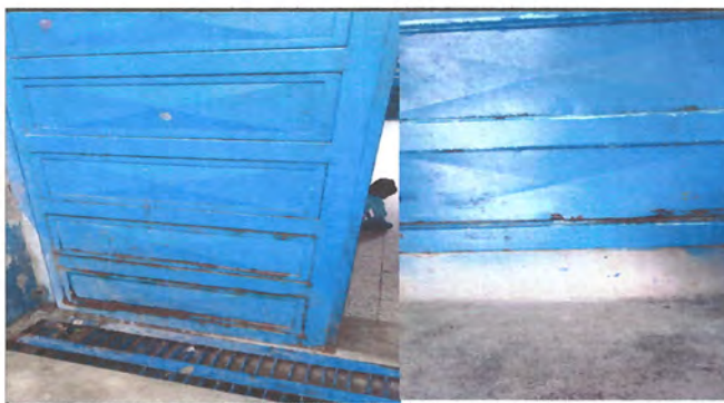
FOTO 4: MANTENIMIENTO PORTON DE METAL
