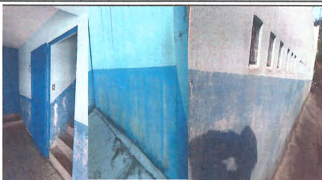
FOTO 2: PINTURA EN MUROS
