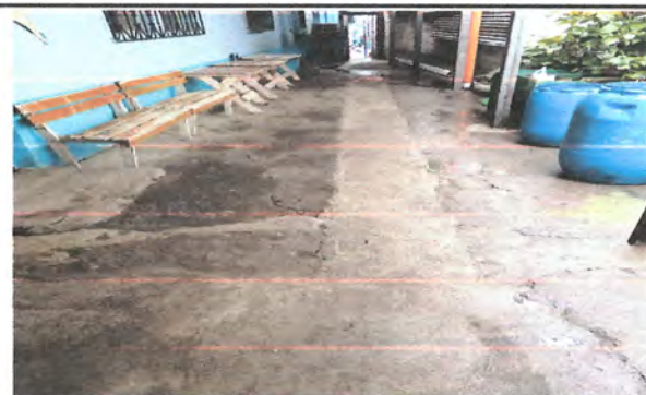
Foto 4: sutitucion de patio de concreto area de aulas y sanitarios
