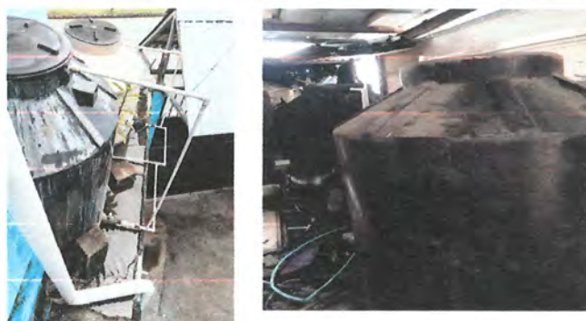
Foto 3 Sustitucion de depositos de agua y bases de concreto
