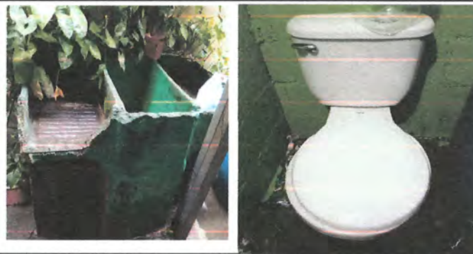
Foto 6: sustitucion de pila y sanitario
