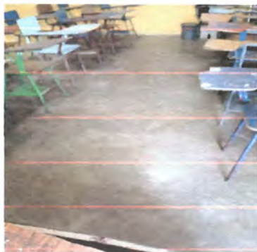
Foto1: sutitucion de piso en aulas
