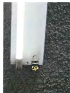
Foto 10: Sustitución de base de lámparas de LISTON 1X18W en área de salón de usos múltiples
