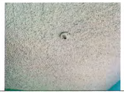
Foto 11: Sustitución de PLAFONERO SIN CADENA BLANCO EAGLE en área de la cocina.
