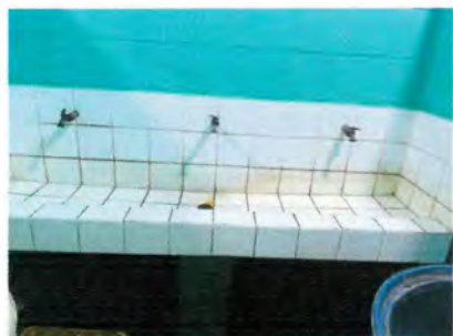
Foto 7: Sustitución de chorros en área de lavado en sanitario 1er nivel de niñas.
