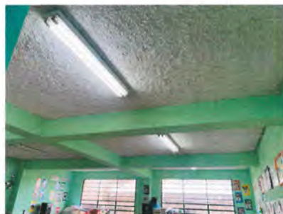
Foto 4: Sustitución de lámparas de candelas a BOMBILLA LED 50W MV DL ROSCA MEDIANA/MOGUL TECNO LITE E INSTALACION DE PLAFONERAS en clases y cambio de Cable Eléctrico Thhn 12 Rojo y Cable Eléctrico Thhn 12
