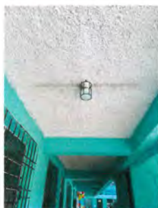
Foto 3: Sustitución de lámparas BOMBILLA LED 50W MV DL ROSCA MEDIANA/MOGUL TECNO LITE, en área de pasillo, área de baño de niños primer nivel, área de baño de niñas primer nivel y cocina.
