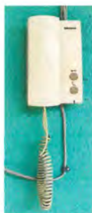
Foto1: Cambio de cable dañado y arreglo de teléfono comunicador
