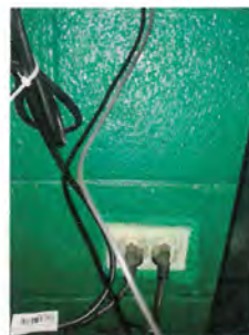
Foto 2: Sustitución de Tomacorriente Doble Blanco en área de Dirección, clase y área de cocina.
