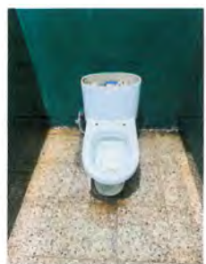
Foto 5: Sustitución de Sanitario Inodoro Redondo Ecoline II Blanco, sustitución de mangueras y llaves y cambio de cuello de cera, en sanitarios de 1er nivel de niños y baño de niñas en primer nivel.
