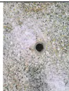
Foto 8: Sustitución de tapadera de drenaje en área de baños
