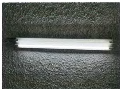
Foto 9: Sustitución de LAMPARA LISTON 1X18W en área de salón de usos múltiples (se cambiará solo la candela) 1 X 18
