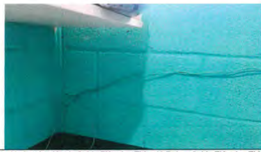
Foto 12: Sustitución de Cable Eléctrico Thhn 12 Rojo y Cable Eléctrico Thhn 12 negro y colocación de canaleta para pared en área de la cocina.
