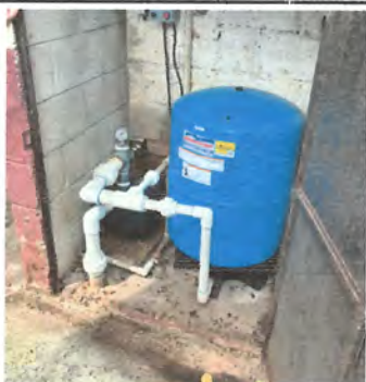
FOTO 5: Sustitución de bomba de agua con deposito hidroneumatico, conexión eléctrica e hidraulica
