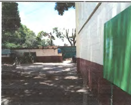
FOTO 3: Instalación de cableado eléctrico bajo tierra hacia posición de bomba de agua
