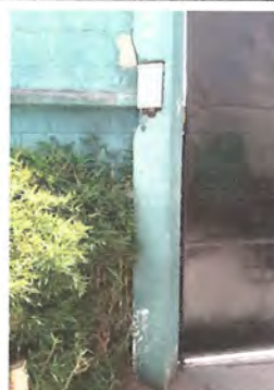
FOTO 4: Conexión de cableado eléctrico desde instalación RH actual hacia bomba de agua
