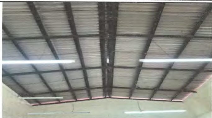
FOTO 1: CAMBIO DE LAMINA
