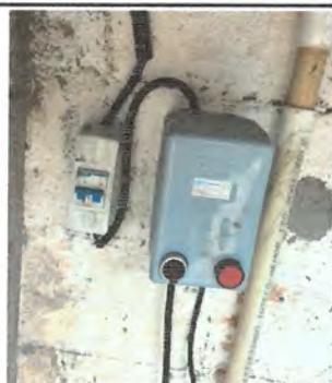
FOTO 6: Instalación de tablero eléctrico para bomba de agua
