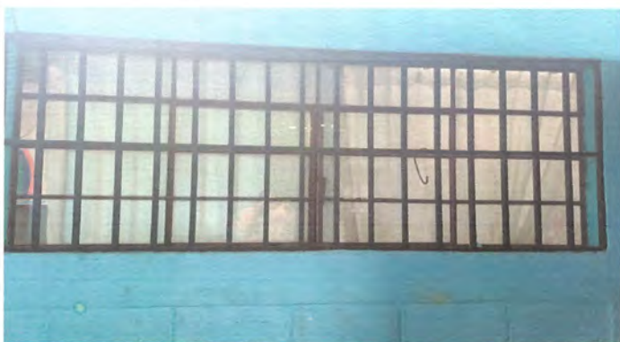
FOTO 3: INSTALACION DE VENTANAS PVC
