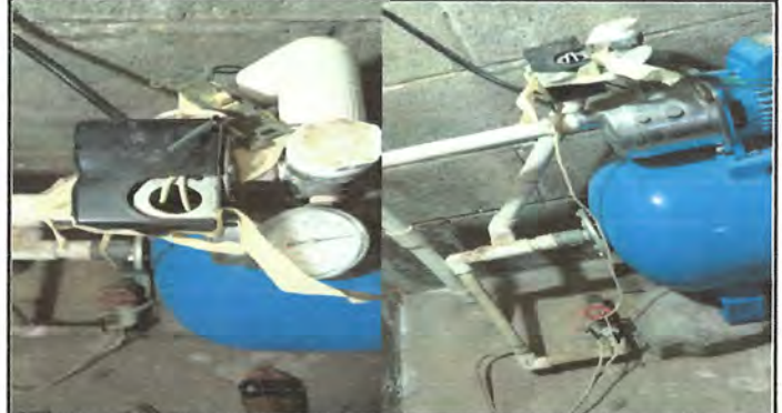
FOTO 8: REPARACION DE SISTEMA ELECTRICO BOMBA DE AGUA
