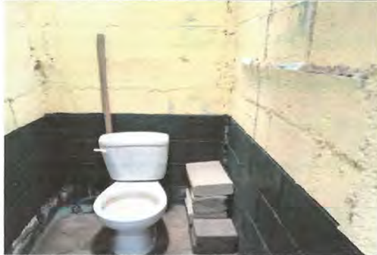
FOTO 7: INSTALACION DE AZULEJO EN BAÑO
