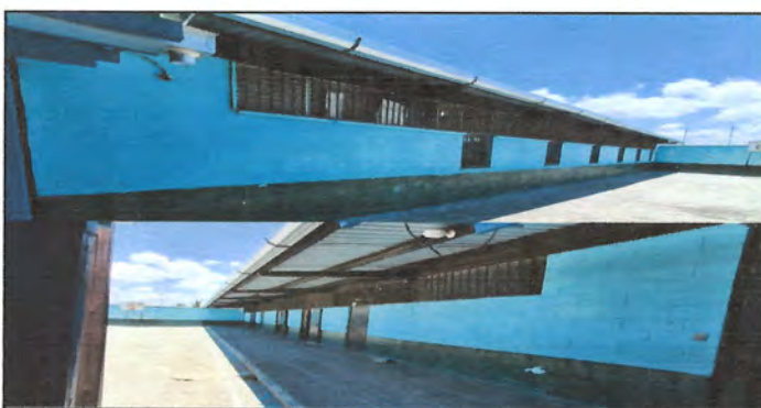
FOTO 5: PINTURA EN MUROS
