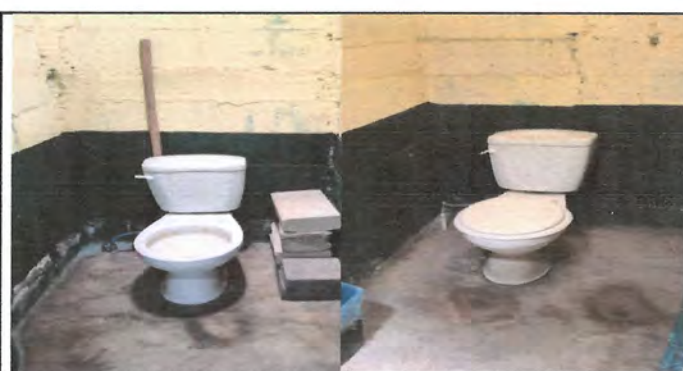
FOTO 6: CAMBIO DE SANITARIOS
