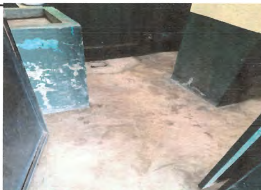
FOTO 4: INSTALACION DE PISO CERAMICO
