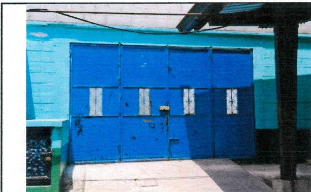
FOTO 3: SUSTITUCION DE PORTON
