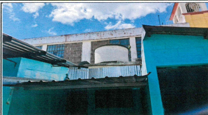
FOTO 1: CAMBIO DE LAMINA POR LAMINA TROQUELADA, ELEVACION DE TECHO, CIERRE CON LAMIA EN AREA DE TINACO/
