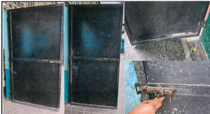
FOTO 4: SUSTITUCION DE PUERTAS DE METAL
