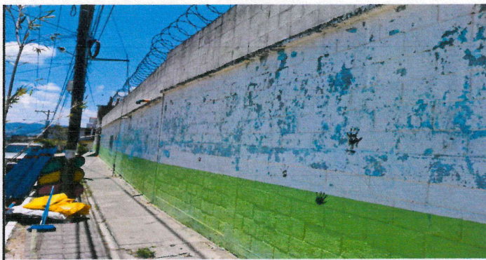
FOTO 6: PINTURA EN MUROS
