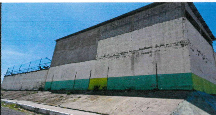
FOTO 5: PINTURA EN MUROS
