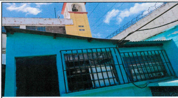
FOTO 2: Cambio de estructura por nuevo diseño, elevacion de techo para continuar techo nuevo,
