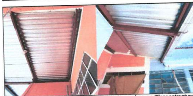
Foto 6: Lámina de área de guadania deteriorada, requiere modificar estructura / TERMINADO
