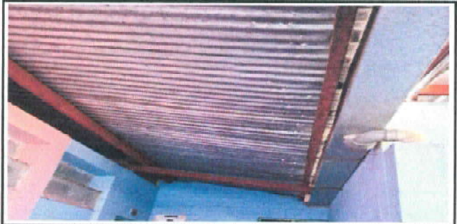
Foto 2: Canal pluvial de area de baños
