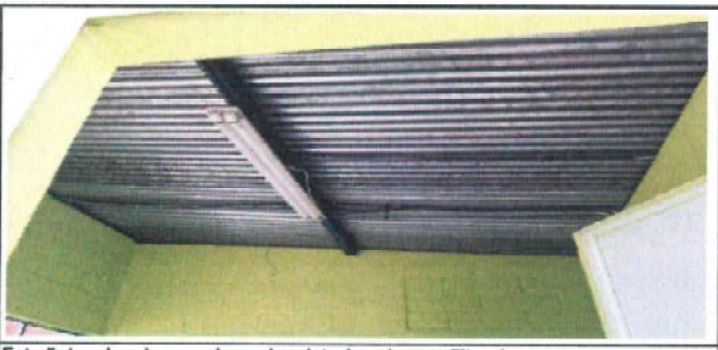
Foto 5: Lamina de area de cocina deteriorada, con filtraciones
