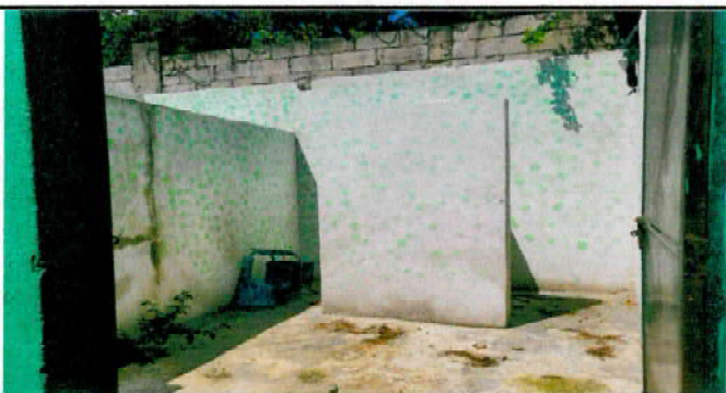
Foto 21: INSTALACION DE PILA EN BODEGA
