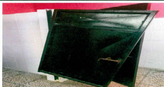
Foto1: REPARACION DE PUERTA DE SANITARIO
