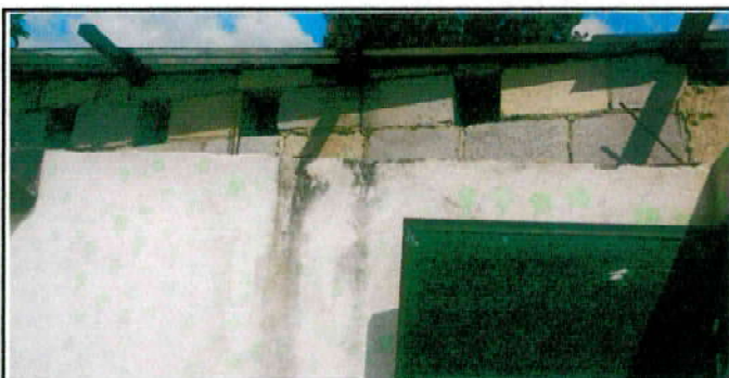
Foto 29: SELLADO DE GRIETAS Y FISURAS EN MUROS
