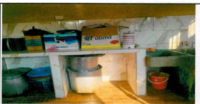
Foto 11: INSTALACION DE PUERTA EN ENCIMERA
