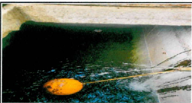
Foto 9: REPARACION DE CISTERNA DE CONCRETO
