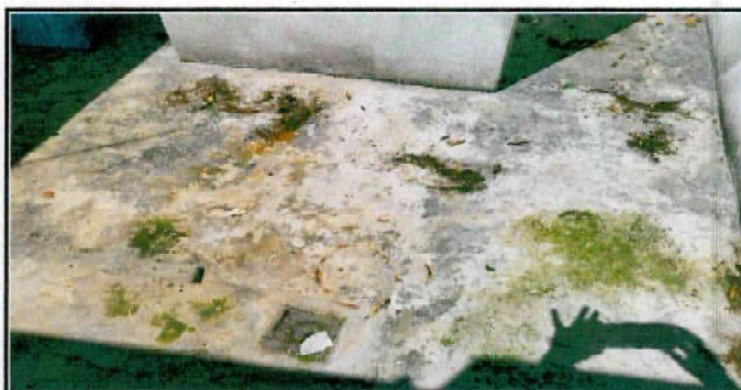
Foto 16: INSTALACION DE PISO DE GRANITO A BODEGA
