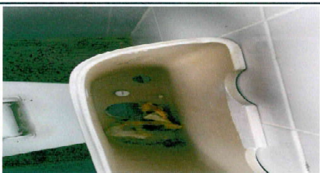
Foto 3: SUSTITUCION DE SANITARIOS
