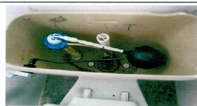
Foto 5: SUSTITUCION DE SANITARIOS
