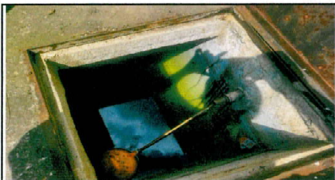
FOTO 27: REPARACION DE CISTERNA
