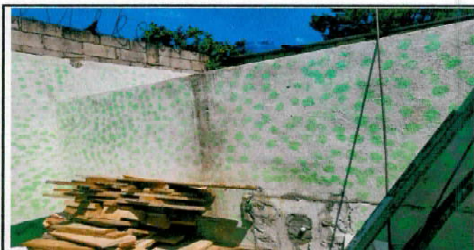
Foto 18: INSTALACION DE VENTANA DE PVC
