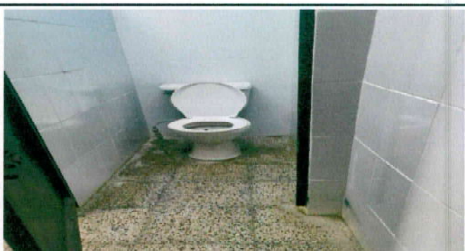
Foto 4: SUSTITUCION DE SANITARIOS
