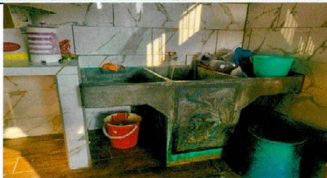
Foto13: SUSTITUCIÓN DE PILA POR PILA DE CONCRETO Y COLOCACION DE AZULEJO
