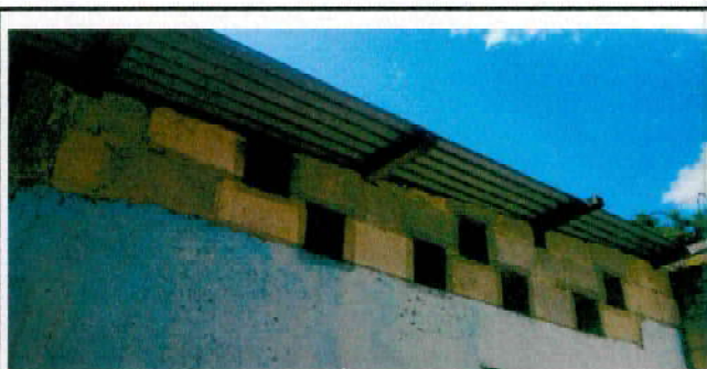
FOTO 28: SELLADO DE GRIETAS Y FISURAS EN MUROS EN SALÓN
