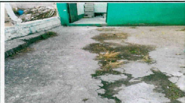
FOTO 26: REPARACION DE PISO DE TORTA DE CONCRETO
