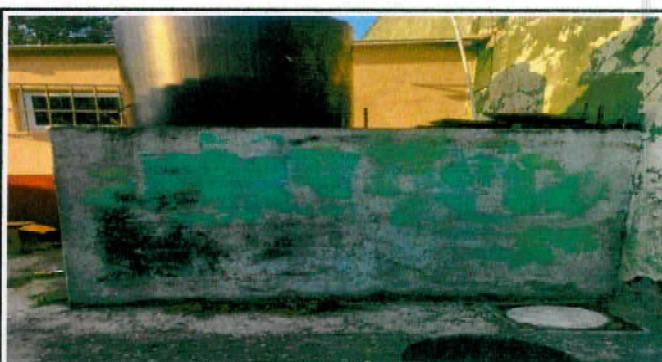
Foto 10: REPARACION DE CISTERNA DE CONCRETO
