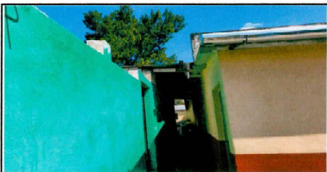
Foto 15: INSTALCION DE TECHO DE LAMINA A BODEGA
