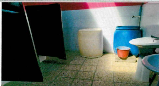
Foto 7: INSTALACION DE AGUA EN SANITARIOS
