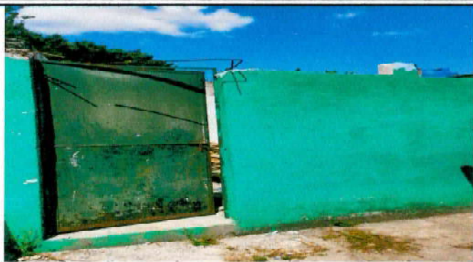
Foto 19: DEMOLICION DE PARED
