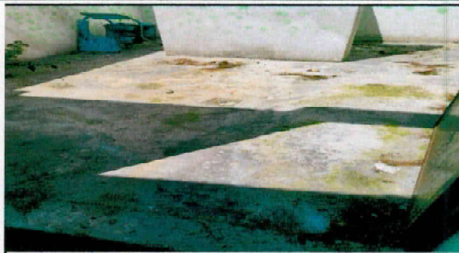
Foto 20: DEMOLICION DE PARED DE BODEGA
