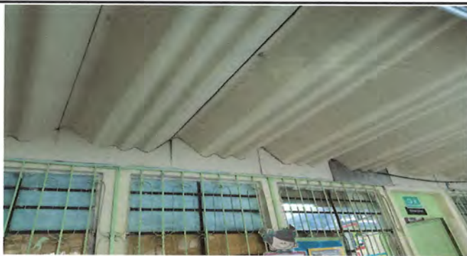
Foto 5: sustitucion de lamina en area de corredor
