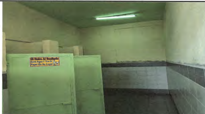
Foto 3: pintura general en el area de baños
