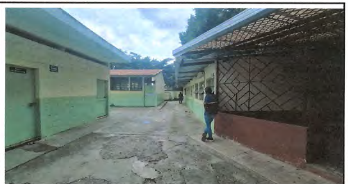
Foto 4: pintura general en muros exteriores y pintura de puertas
