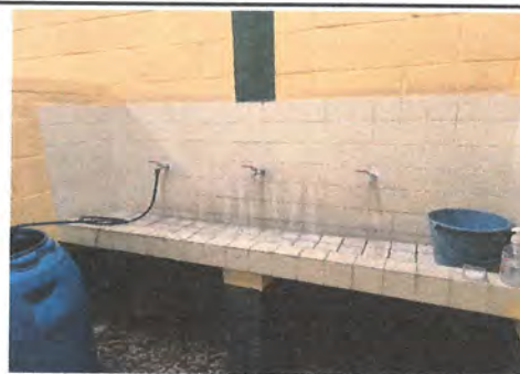
Foto 6: 6.3 SUSTITUCION DE AZULEJO EN LAVAMANOS.
