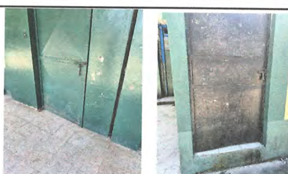
Foto 4: 4.2 SUMINISTRO E INSTALACION DE CHAPAS YALE LARGAS PARA PUERTAS DE METAL
