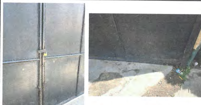
Foto 2: 12.1 SUMINISTRO E INSTALACIÓN DE CHAPA DE ENGRAPE MARCA YALE PARA PORTON PRINCIPAL, INCLUYE CEPILLADO Y PINTURA EN SU TOTALIDAD
