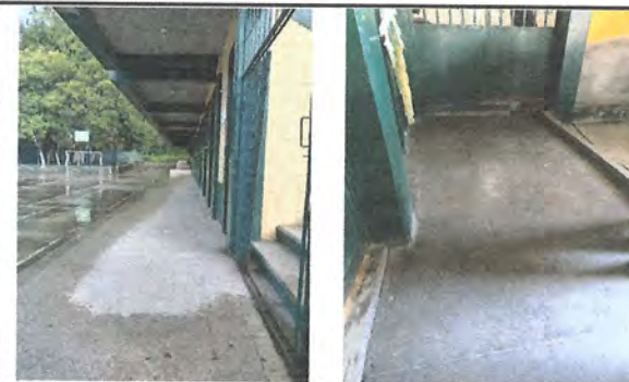
Foto 4: 6.1 SUMINISTRO E INSTALACION DE PISO CERAMICO DE 33*33CM EN AREA DE PASILLO
