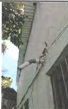
Foto1: 7.1 SUMINISTRO E INSTALACION DE CANAL ROJO TEJA, FERROMAX, CALIBRE 26 + PESCANTE DE TUBO CUADRADO Y BAJADA DE AGUA PLUVIAL DE 4" 80 PSI COLOR BLANCO
