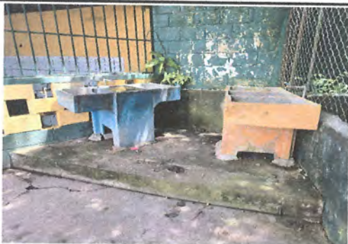
Foto1: 1.1 SUMINISTRO E INSTALACION DE CUBIERTA DE LAMINA PARA EL AREA DE PILAS
