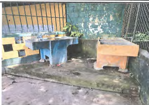
Foto 2. SUMINISTRO E INSTALACION DE BAJADA DE AGUA PLUVIAL DE 3" 80 PSI CON SUS RESPECTIVOS CODOS (PARA EL AREA DE PILAS)
