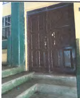
Foto 5: 4.3 SUSTITUCION DE PUERTA DE MADERA POR PUERTA DE PVC COLOR MADERA DE 2 HOJAS
