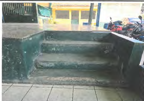
Foto 3. 8.2 REPARACION DE GRADAS EN AREA DE ESCENARIO, INCLUYE FUNDICION DE 2 HUELLAS CON UN PROMEDIO DE 7CM
