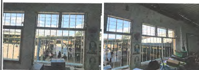
Foto 6: 5.2 SUSTITUCION DE VENTANERA DE ALUMINIO POR PVC BLANCO CON VIDRIO CLARO Y MOSQUITERO
