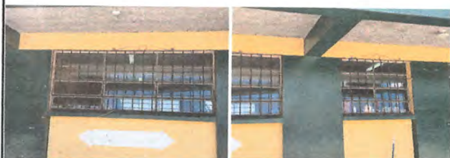
Foto1: 5.7 MANTENIMIENTO DE BALCONES, INCLUYE LIJADO Y PINTURA
