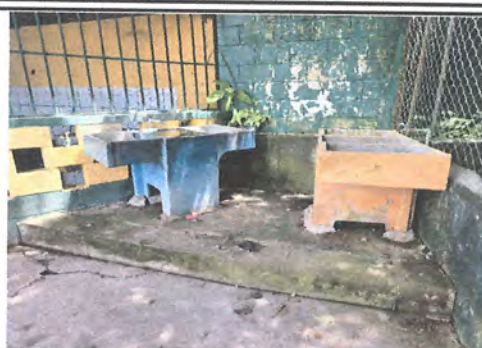
Foto 2: 2.1 SUMINISTRO E INSTALACION DE ESTRUCTURA METALICA PARA AREA DE PILAS
