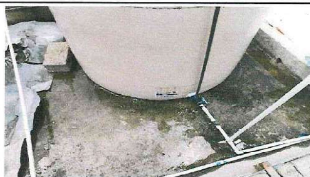
Foto 2: Suministro y aplicación de impermeabilizante.
