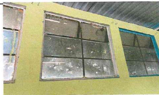
Foto 4: Sustitución de ventanas de metal por pvc, lo que permitira una mejor ventilación en los salones.
