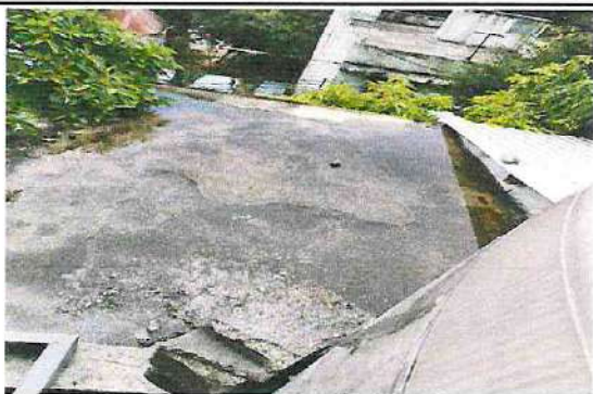
Foto 1: Suministro y aplicación de mezlón
