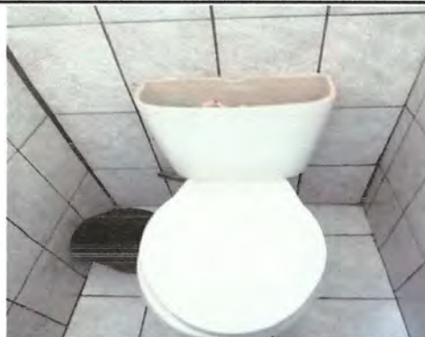
Foto 2: Sustitución de inodoro de niños
