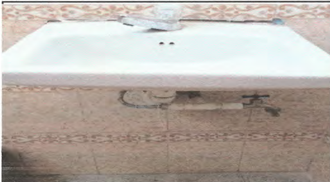
Foto 3: Sustitución de lavamanos completo en baño de dirección
