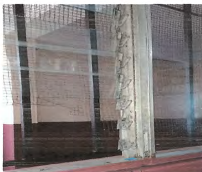
Foto 3: Sustitución de estructura de metal de ventana
