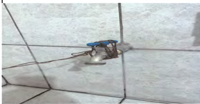
Foto 4: Sustitución de chorro en el área sanitario de niñas
