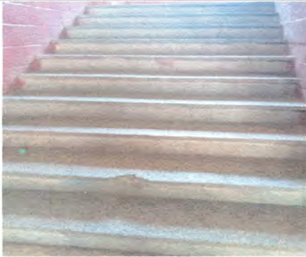
Foto1: Reparacion de piso de granito con concreto
