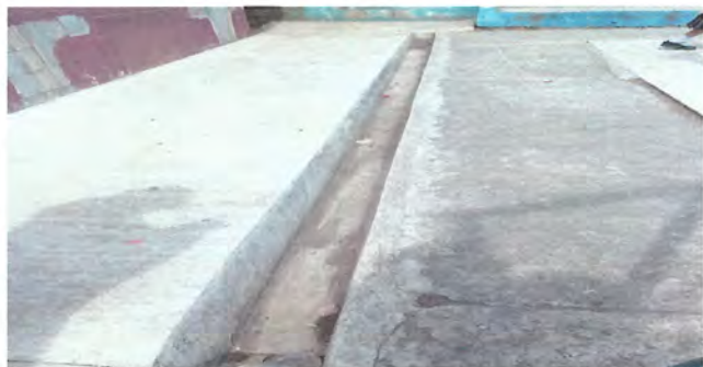
Foto 5: Reparación de cuneta con rejilla
