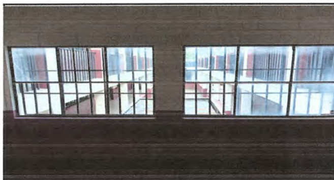
Foto 6: Sustitución de vidrios área de gradas
