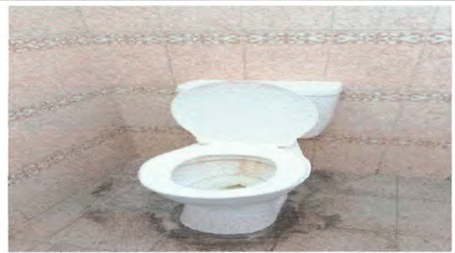
Foto 2: Sustitución de sanitario completo tipo push en baño de dirección
