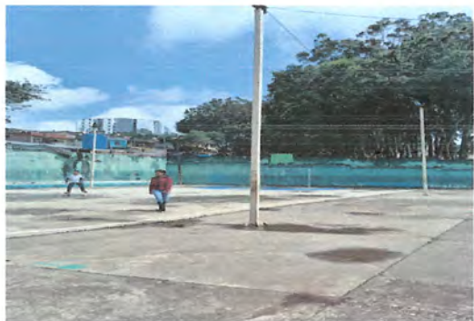
Foto 1: Sustitución de Estructura de soporte de metal, por metal.
