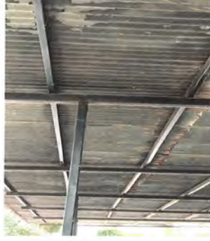
Foto1: Sustitución de lámina acanalada por lamina troquelada aluzinc calibre 26. Instalación de canal de PVC
