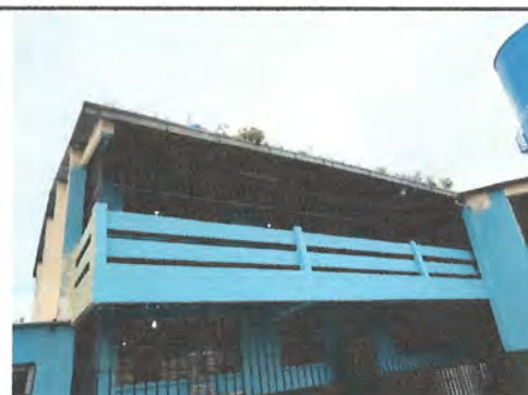
Foto 6: Mantenimiento a baranda de metal
