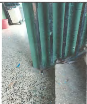
Foto 11: Sustrucción de baranda de metal por metal
