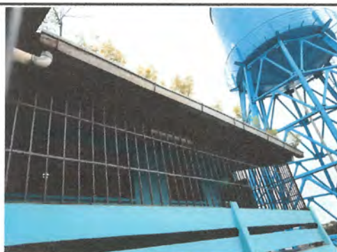
Foto 5: Sustitución de canal de metal
