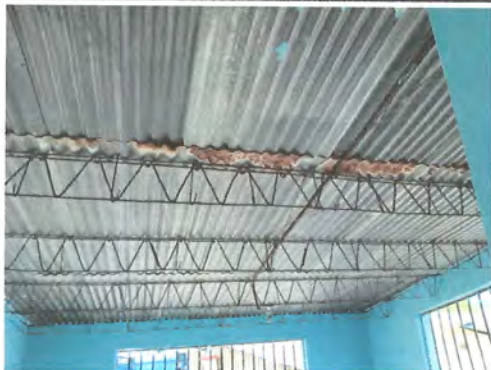
Foto1: Mantenimiento de estructura de soporte de metal
