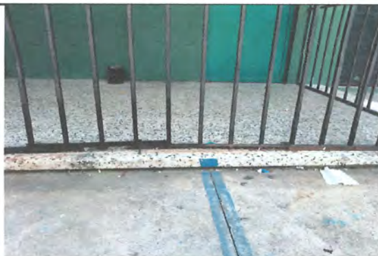
Foto 9: Sustrucción de Baranda de metal por metal
