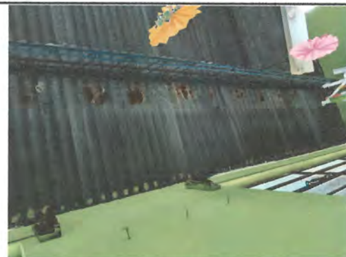
Foto 3: Sustitución de lamina por lamina troquelada
