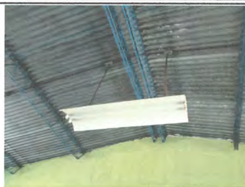
Foto 8: Sustrucción de lamparas
