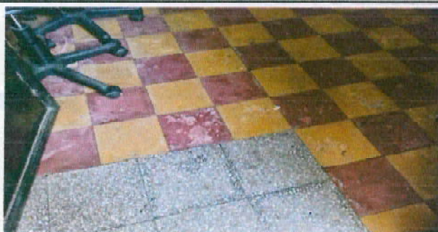
Foto 3: Remozamiento de piso.
