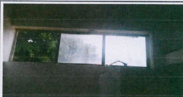
Foto 6: Sustitución de ventana de metal por pvc
