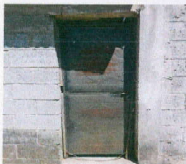
Foto 1: Remozamiento de pintura en puertas de metal
