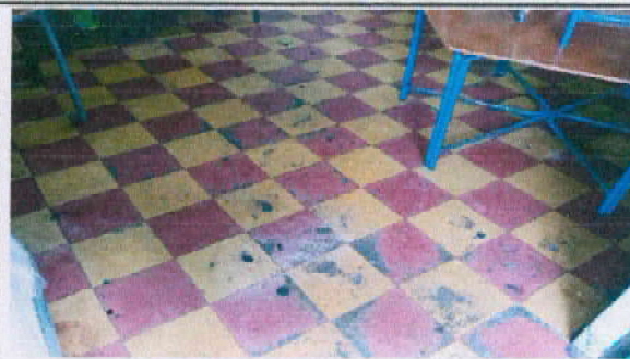
Foto 4: Remozamiento de piso.
