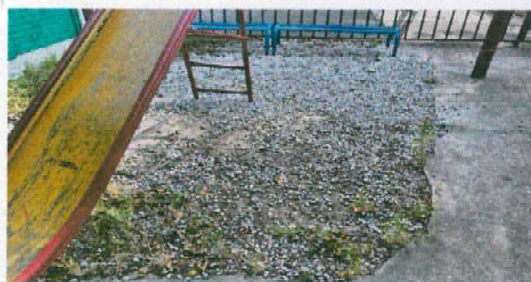
Foto 5: Remozamiento de torta de patio.
