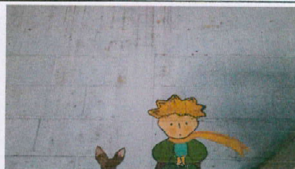
Foto 4: Remozamiento de pintura en interiores.
