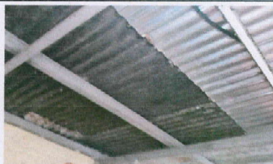
Foto 2: Remozamiento de techo.
