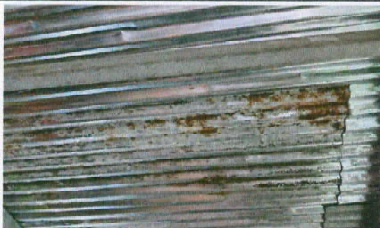
Foto1: Remozamiento de techo.
