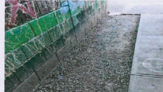
Foto 6: Remozamiento de torta de patio.
