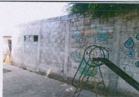
Foto 2: Remozamiento de pintura en exteriores
