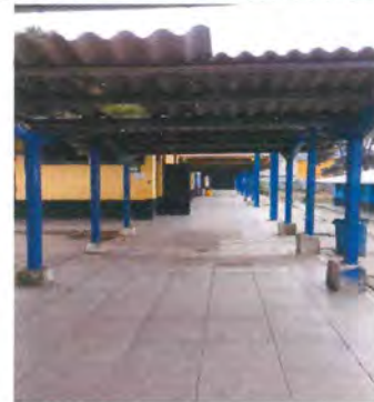
Foto 4: Sustitución de canal de metal, sustitución de bajada de agua pluvial de metal por tubo pvc3" en pasillos
