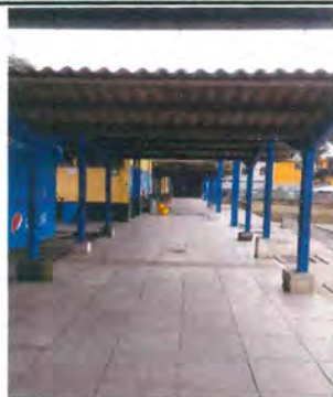
Foto 5: Sustitución de canal de metal, sustitución de bajada de agua pluvial de metal por tubo pvc3" en pasillos
