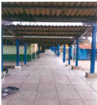
Foto 3: Sustitución de canal de metal, sustitución de bajada de agua pluvial de metal por tubo pvc3" en pasillos
