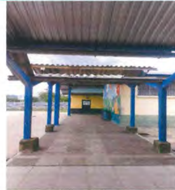
Foto 2: Sustitución de canal de metal, sustitución de bajada de agua pluvial de metal por tubo pvc3" en pasillos
