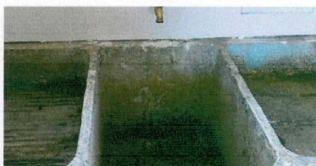
Foto 4: Instalación de pila por deterioro
