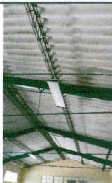
Foto 1: Sustrucción de lámina de duralita instalado hace 50 años por lámina troquelada aluzinc.
