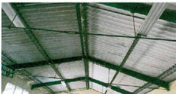
Foto 3: sustrucción de canales de metal.
