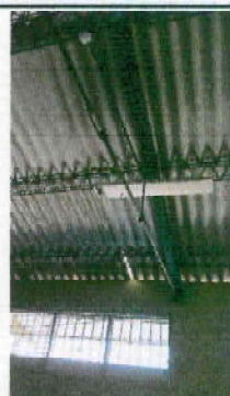
Foto 2: Cambio de lamparas de energia electrica
