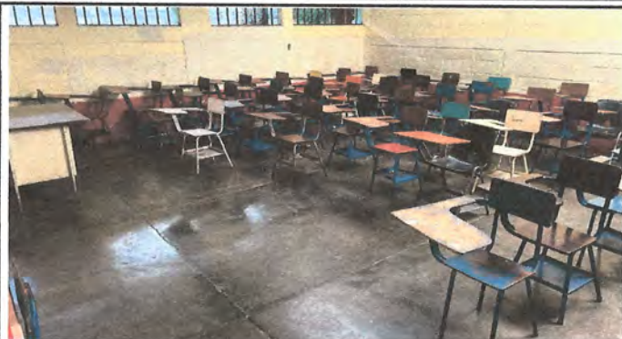
Foto1: SUSTITUCIÓN DE PISO DE GRANITO EN AGULAS
