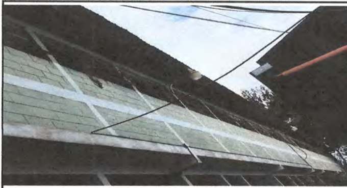
Foto 3: RECICLAJE DE VENTANALES DE METAL POR BALCONES
