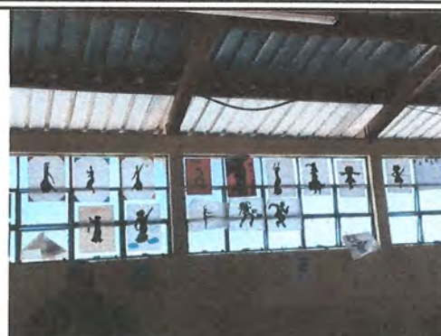
Foto 2: CAMBIO E INSTALACIÓN DE VENTANAS DE METAL POR PVC
