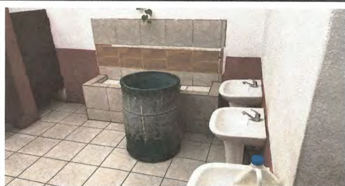
Foto 3: SUSTITUCION MIJITORIO COLECTIVO DE CONCRETO POR MIJITORIO INDIVIDUAL.
