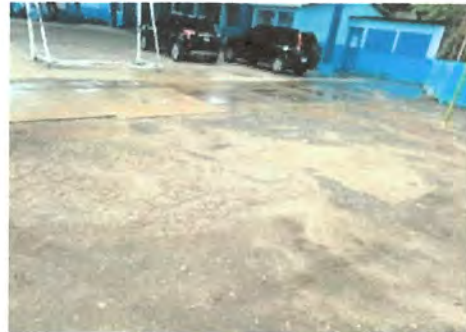
Foto 2: Reparación de piso de torta de concreto
