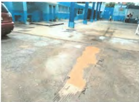
Foto1: Reparación de piso de torta de concreto
