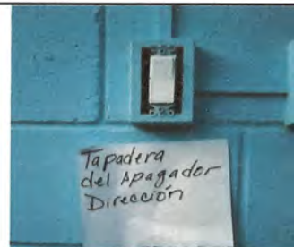
Foto 6: Sustitución de interruptor simple en dirección
