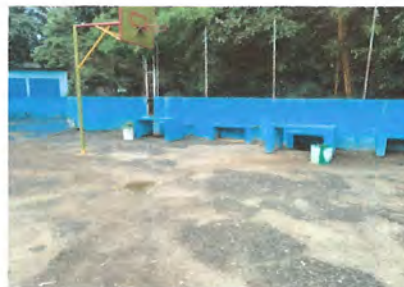
Foto 4: Reparación de piso de torta de concreto
