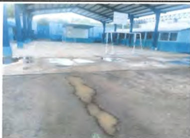
Foto 5: Reparación de piso de torta de concreto
