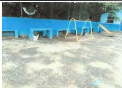
Foto 3: Reparación de piso de torta de concreto
