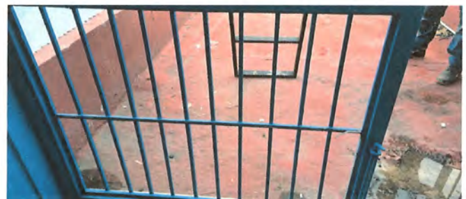
FOTO 6: SUSTITUCION DE VIDRIOS
