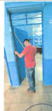
FOTO 6: FABRICACION E INSTALACION DE PUERTA DE REJAS
