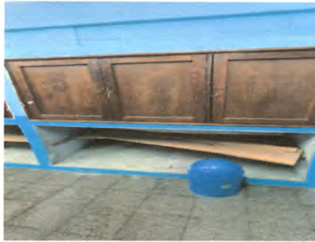
FOTO 1: SUSTITUCION DE PUERTAS
