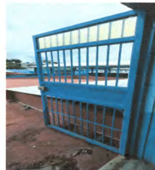
FOTO 4: SUSTITUCION DE VIDRIOS
