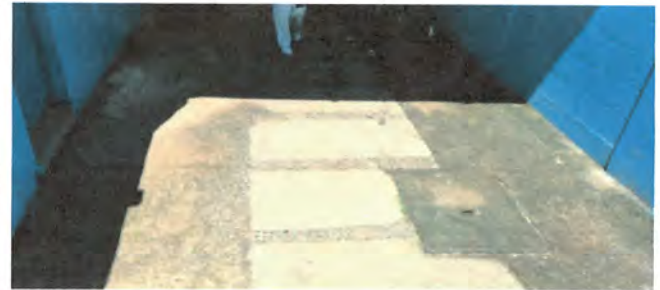
FOTO 2: REPARACION DE PISO DE TORTA DE CONCRETO
