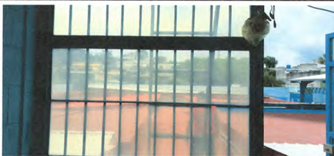
FOTO 5: SUSTITUCION DE VIDRIOS
