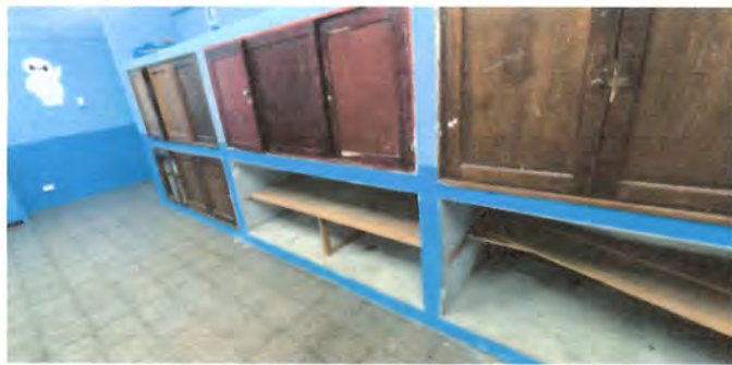
FOTO 3: SUSTITUCION DE PUERTAS
