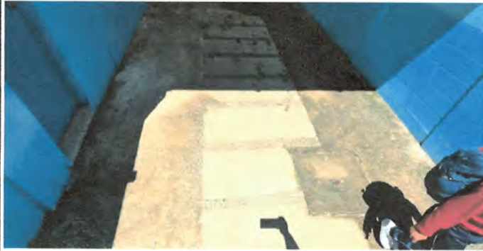
FOTO 1: REPARACION DE PISO DE TORTA DE CONCRETO
