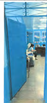
FOTO 4: FABRICACION E INSTALACION DE PUERTA DE REJAS
