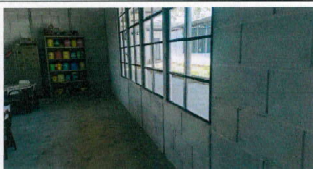
Foto 4: Instalación de tomacorrientes
