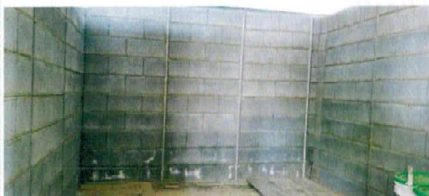
Foto 9: Fabricación de entrepaños en bodega de cocina
