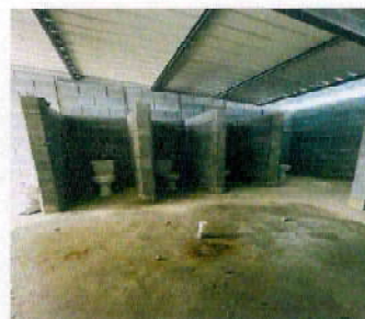
Foto 6: Instalación de piso en sanitarios de niños y niñas
