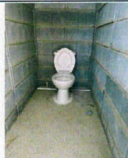
Foto 12: Instalación de piso en baños de docentes
