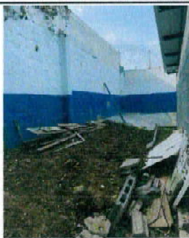
Foto 7: Lugar donde se instalará tinaco, para distribución de agua en baños de niños y niñas
