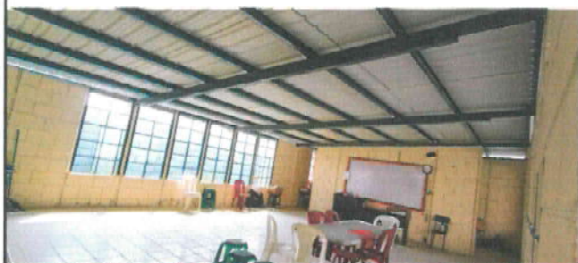
Foto 1: Arreglo del sistema eléctrico del Módulo 1 (sala de maestros)
