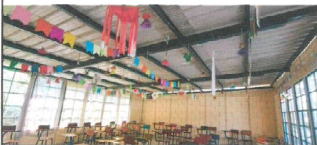
Foto 3: Arreglo del sistema eléctrico en los salones de clases del Módulo 3 (5to. Bachillerato B y C)
