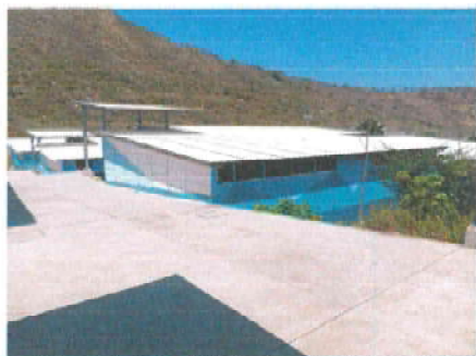
Foto 7: Colocación de postes para la colocación de cableado para la conexión de los módulos 1 y 3, 3 y 5 e iluminación
