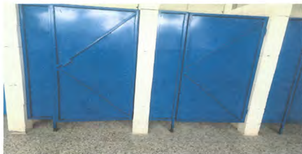
Foto1: Mantenimiento a estructura (lijado cepillado y aplicación de pintura a puertas de servicio sanitario)
