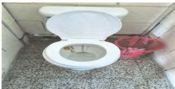
Foto 3: sustitucion de accesorios de inodoros en tanque de agua y limpieza profunda por sarro
