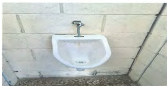
Foto 4: manrenimiento de mingitorios y sustitucion de llaves
