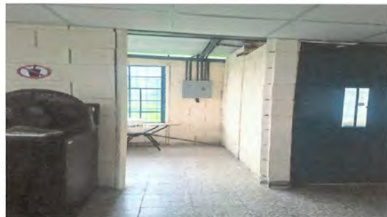
Foto 8: fabricación e instalación de puerta en bodega de salon de computacion
