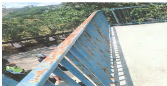
Foto 6: Mantenimiento a estructura (lijado cepillado y aplicación de pintura en barandas)
