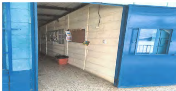
Foto 10: fabricacion e instalacion de puertas de rejas
