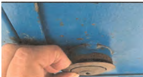
Foto 9: sustitucion de chapas en puertas de aulas
