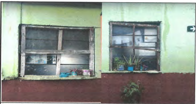
Foto 5: Sustrucción de balcones de madera por metal , 12 balcones.
