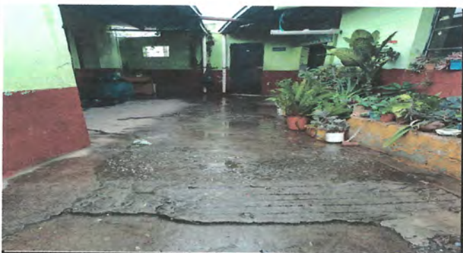
Foto 3: Cambio de 36 metros de concreto con electromalla, extraer y sustituir por una base nueva con un grosor de 10 cms.
