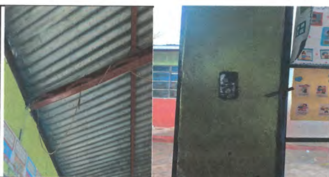
Foto 6: Reparación de cable electrico 400mts. Sustrucción de ducto electrico mas accesorios( 7 focos ahorradores, 7 plafoneras, 7 interruptores simples y 21 tomacorrientes dobles)
