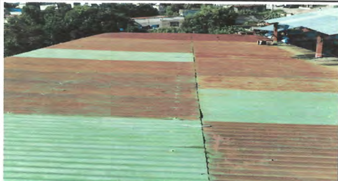
Foto 1: Sustrucción de lamina troquelada aluzinc calibre 26, desmontaje y montaje, incluye mantenimiento de estructura y soporte de metal
