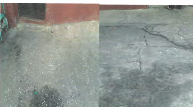
Foto 4: Cambio de 36 metros de concreto con electromalla, extraer y sustituir por una base nueva con un grosor de 10 cms.
