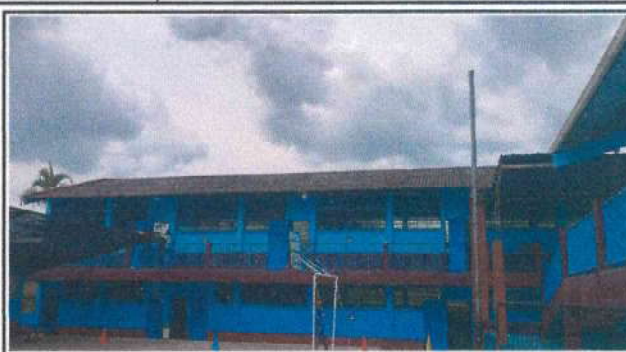
Foto 2: Instalacion de capote de lámina para lamina troquelada para 4 salones: 2 de quinto A y B, 2 de sexto A y B.
