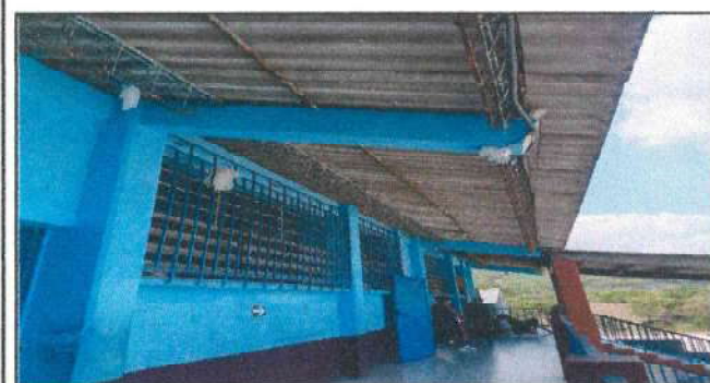
Foto 3: Sustitución de lámina de duralita por lamina troquelada calibre 26, aluzinc.
