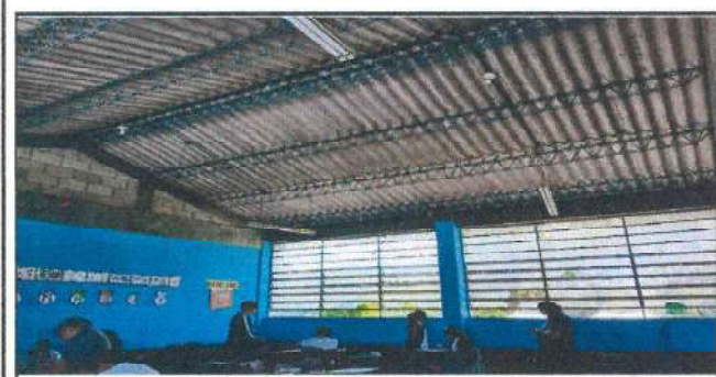
Foto 5: ESTRUCTURA DE TECHO : Mantenimiento a estructura de soporte de metal a 4 salones: 2 de quinto A y B, 2 de sexto A y B.
