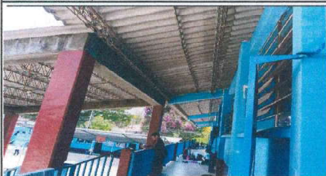
Foto1: CUBIERTA DE LAMINA: Sustitución de lámina duralira por lámina troquelada calibre 26, legitima, aluzinc a 4 salones: 2 de quinto A y B, 2 de sexto A y B, ubicados en el segundo nivel.
