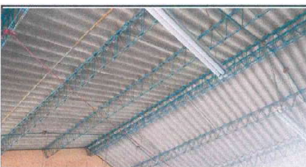
Foto 6: Mantenimiento a estructura de metal
