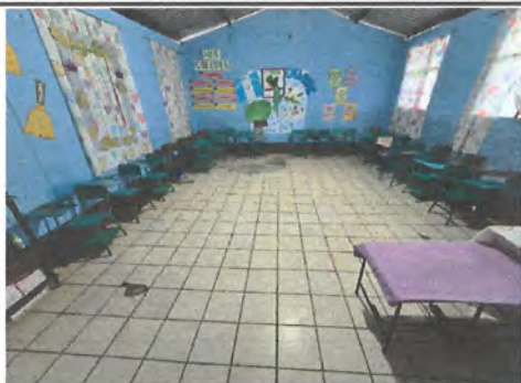
Foto 18: Sustrución de piso ceramico por piso de granito 6to B
