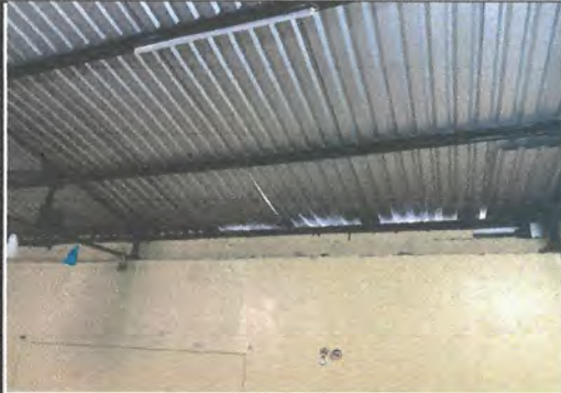
Foto 1: Sustitución de laminas por deterioro.
