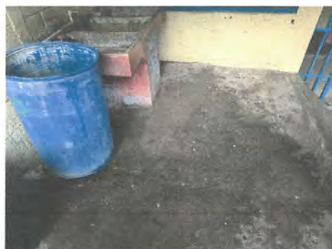
Foto 23: Piso en el area de pila
