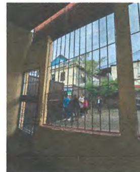
Foto 4: Sustitución y ampleación de puerta, instalación de porton de metal en la entrada principal, este porton sustituirá una puerta ya existente muy reducida, debido a que se aglomeran los niños en caso de emergencia.
