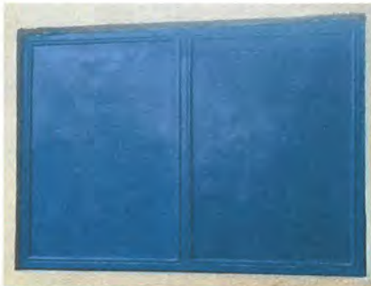
Foto 12: Instalación de valcon de cocina
