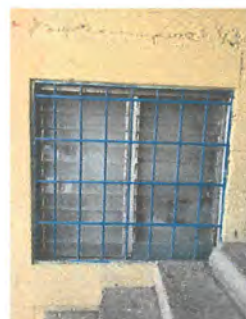
Foto 15: Sustrución de balcón de bodega
