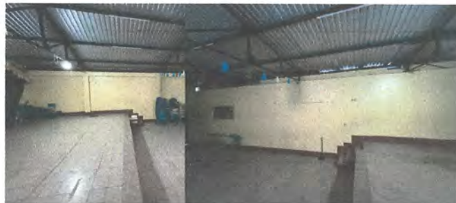
Foto 21: Sustitución de tomacorrientes dobles 120 Voltios
