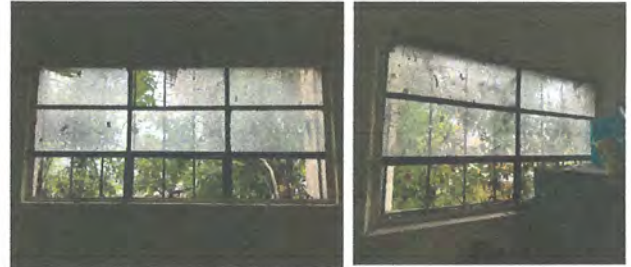
Foto 8: Sustrución de ventanas salón usos multiples
