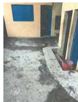
Foto 19: Sustrución de tubería de drenaje
