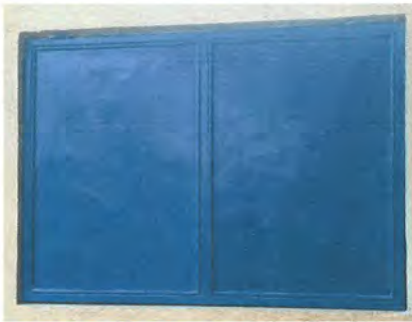
Foto 9: Sustrución de ventana de cocina por una corrediza pvc
