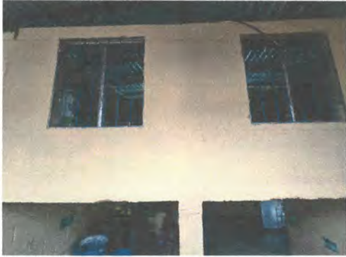
Foto 7: Sustrución de ventanas Dirección
