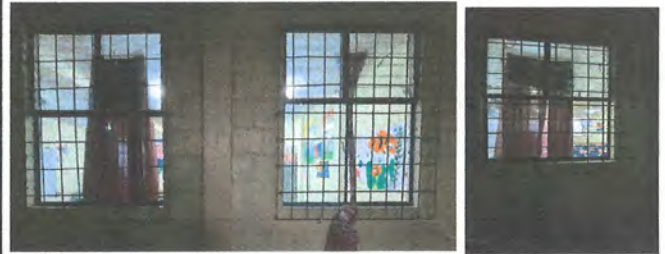
Foto 11: Sustrución de balcones de metal 4to primaria
