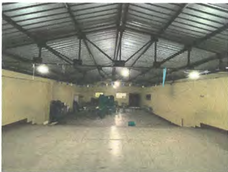
Foto 20: Sustitución de lamparas
