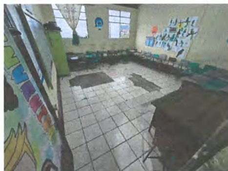
Foto 17: Sustrución de piso ceramico por piso de granito 5to B
