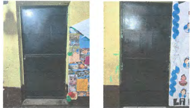
Foto 2: Reparación de puertas por instalación de piso de granito
