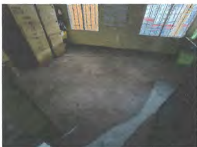
Foto 16: Sustrución de piso de torta de concreto por piso de granito Dirección
