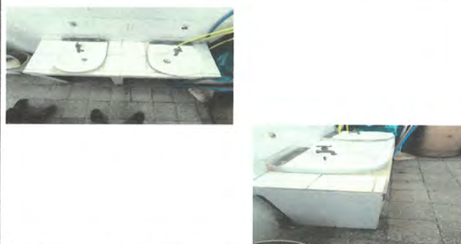
Foto 8 demolicion de planchas fundidas para base de lavamanos y se colocara azulejo nuevo
