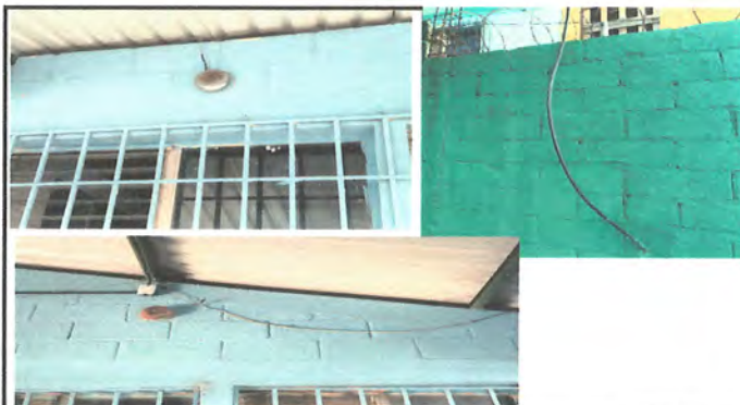
Instalacion de cableado eléctrico con tubo ducto y sustitucion de 3 timbres
