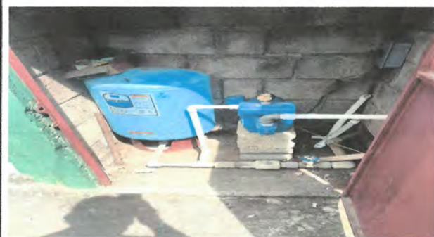
Sustitución de bomba de agua para la cisterna
