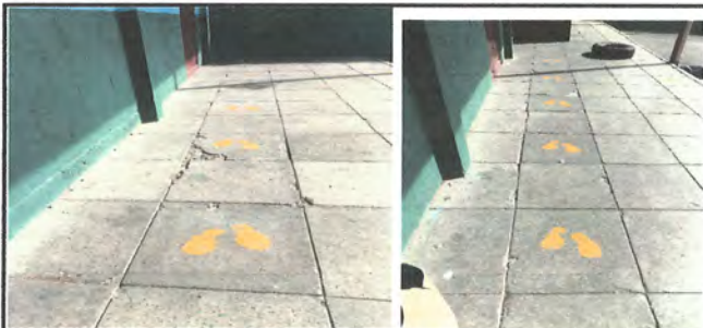
Foto7: banqueta de concreto pasillos de aulas
