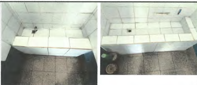
FOTO 15 Sustitución de mingitorio, suministros y mano de obra
