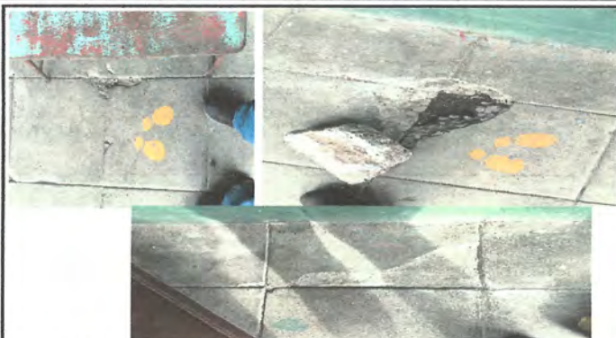
Foto1: SUSTITUCION DE PISO DAÑADO
