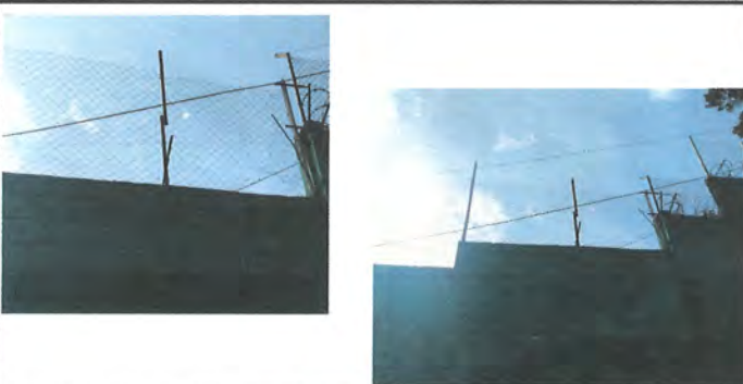
foto 17 Sustitucion de maya galvanizada en muro perimetral suministro y mano de obra
