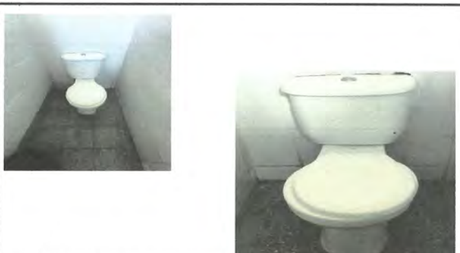
Foto 10: Sustitucion de azulejos
