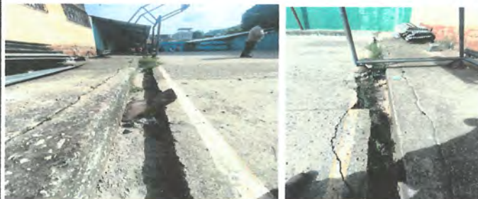
foto 13 Reparación de cuneta de concreto
