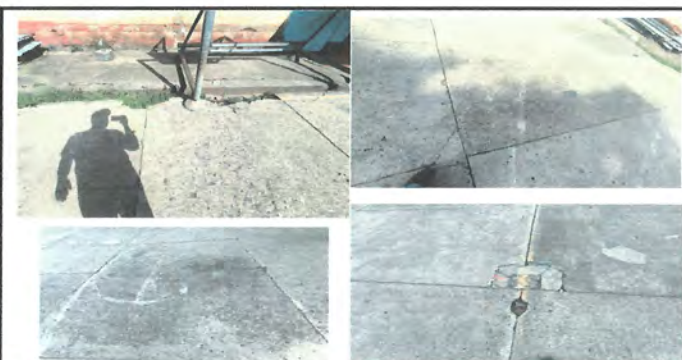
Foto 11: reparacion de torta de concreto de cancha
