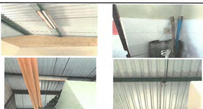
Foto 12 Instalacion de cableado electrico en sanitarios 4 lamparas contra humedad y polvo 4 interruptores sencillos
