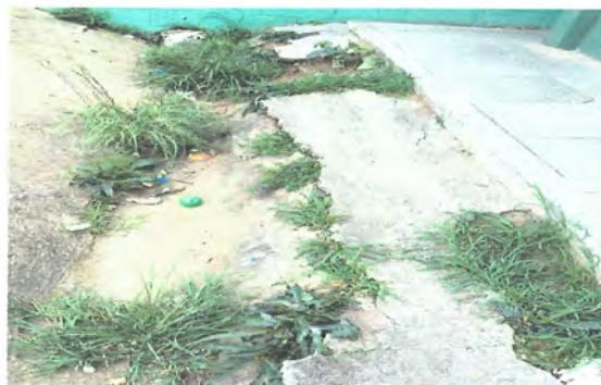
Foto 2: REPARACION DE CUNETAS
