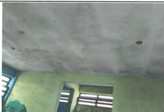
Foto 6: Sustitución de plafoneras
