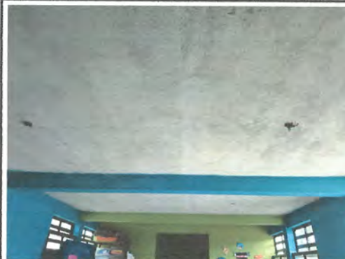
Foto 2: Sustitución de plafoneras
