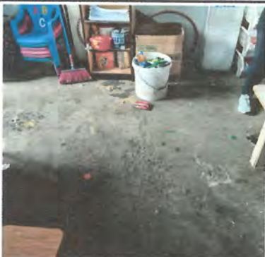
Foto 9: Sustitución de torta por piso cerámico
