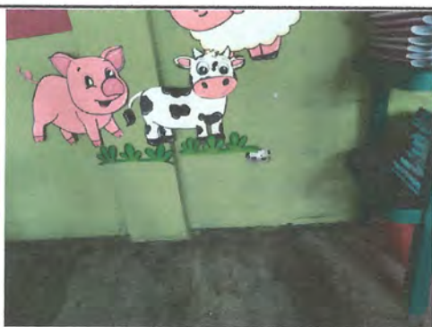
Foto 5: Sustitución de tomacorrientes
