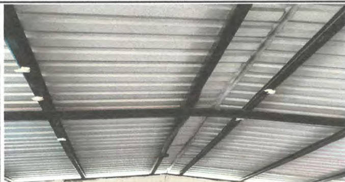
Foto1: LÁMINA CON GOTERAS
