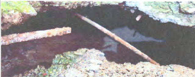
FOTO 3: REPARACION Y RELLENO DE BANQUETA
