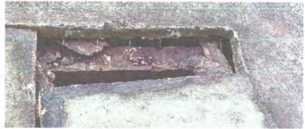
FOTO 2: REPARACION Y RELLENO DE BANQUETA
