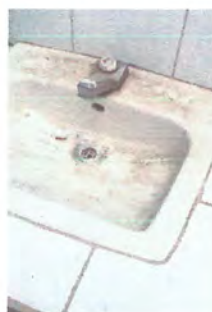
FOTO 4: SUSTITUCION DE LAVAMANOS Y ACCESORIOS
