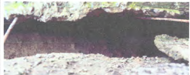
FOTO 4: REPARACION Y RELLENO DE BANQUETA
