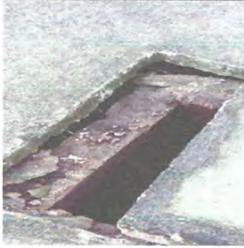
FOTO 1: REPARACION Y RELLENO DE BANQUETA
