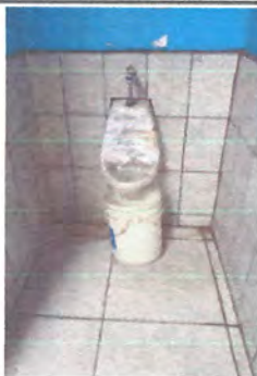
FOTO 1: REPARACION Y CAMBIO DE ACCESORIOS PARA MINGITORIOS
