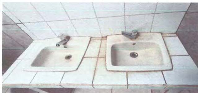
FOTO 3: SUSTITUCION DE LAVAMANOS Y ACCESORIOS
