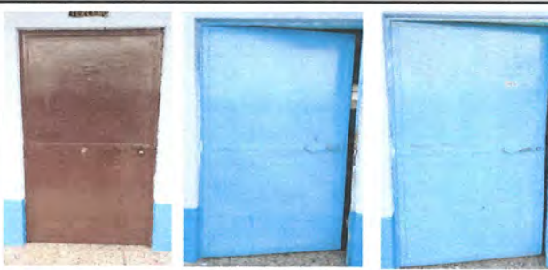
FOTO 16: Remosar puertas de metal
