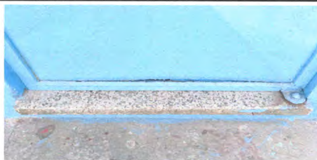
FOTO 14: Remosar puertas de metal
