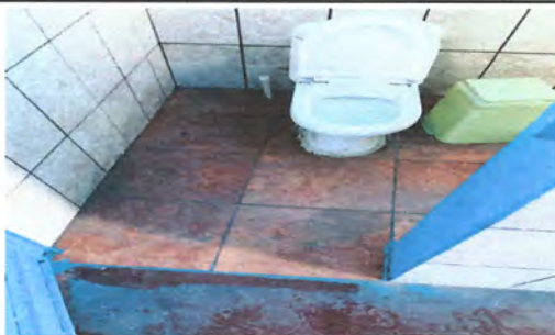
FOTO 15: levantado de piso en cubiculos de baños de niños
