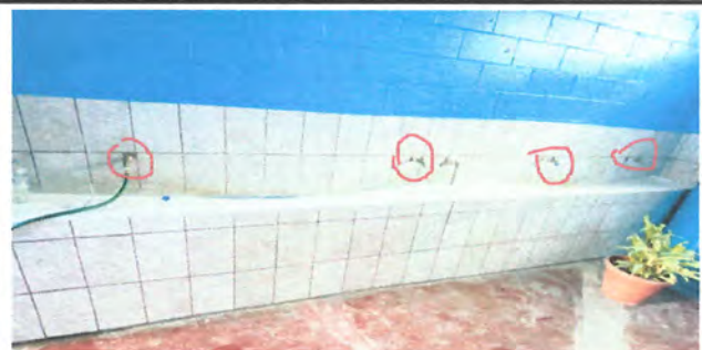
FOTO 8: Reparacion de chorros, tubería interna y cambio de azulejos despues de reparado. Cambio de chorros
