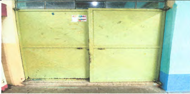
FOTO 7: Remosamiento de porton 2do primaria
