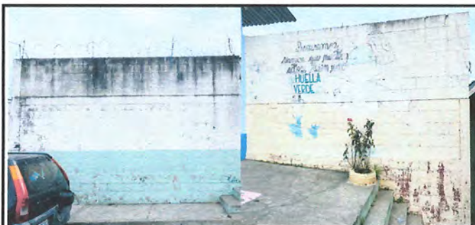
FOTO 5: Pintura en muros
