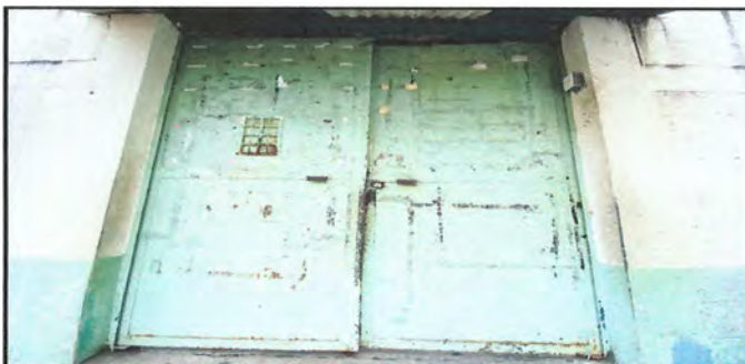
FOTO 3: Cambiar porton de entrada principal
