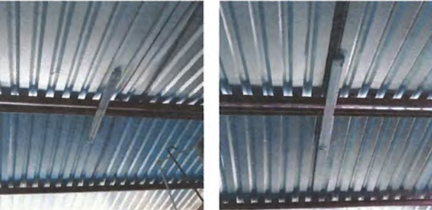
FOTO 9: CAMBIO DE LAMPARAS EN BAÑOS
