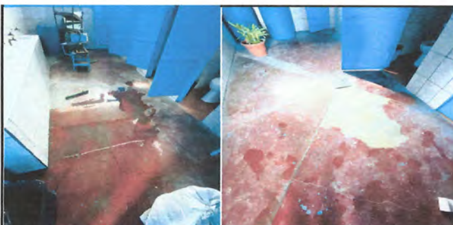
FOTO 4: Instalacion de piso ceramico en area de baños
