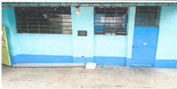
FOTO 13: Instalacion de balcones
