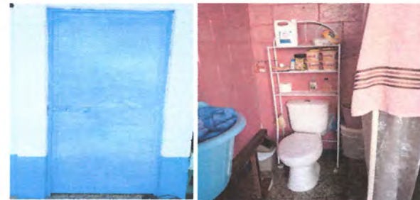
FOTO 11: Sellado y reubicacion de puerta de baño de guardiania
