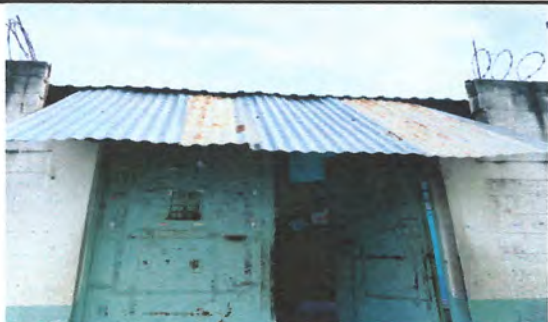
FOTO 1: Cambio de techo y hacer estructura para sombre de ingreso principal con canal
