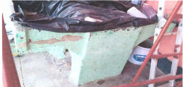
FOTO 10: Cambio de pila de dos lavaderos
