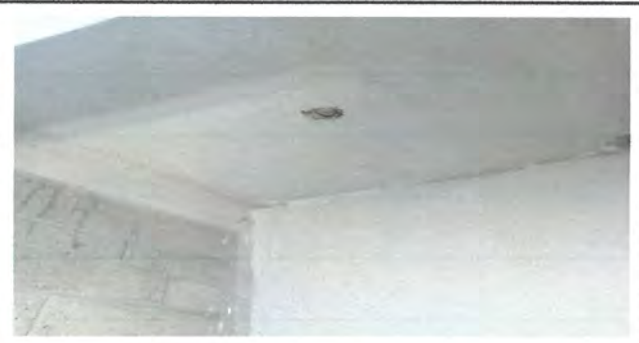
Foto 10: Instalación de unidades luz. En cuatro sanitarios (incluye interruptor, ducto, cable eléctrico)
