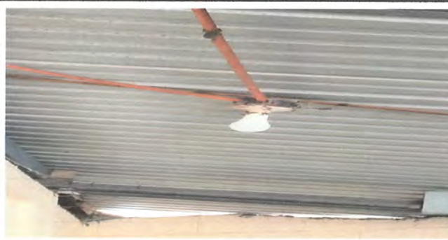
Foto 9: Sustrucción de ducto de tubería de PVC de 1/2 con abrazadera y accesorios
