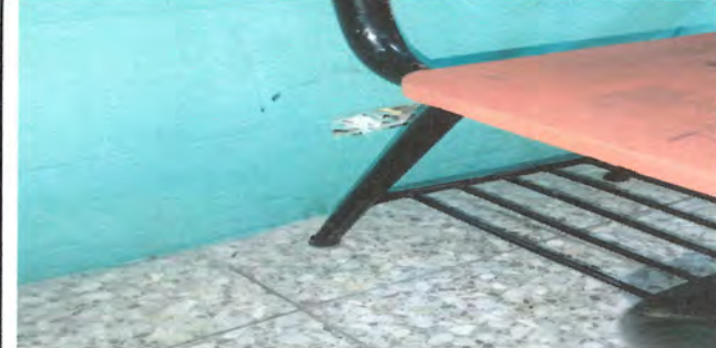
Foto 06: Sustitución de interruptor doble
