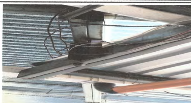
Foto 8: Sustrucción de cableado eléctrico 800 mts. Lineales
