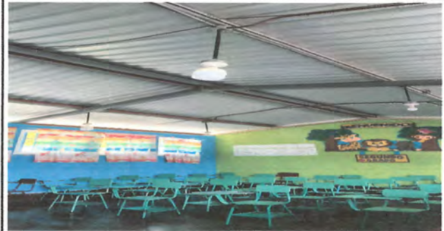
Foto 2: Sustitución de lámparas LED en diez salones contra polvo y humedad 45 pul. p/2 tubos
