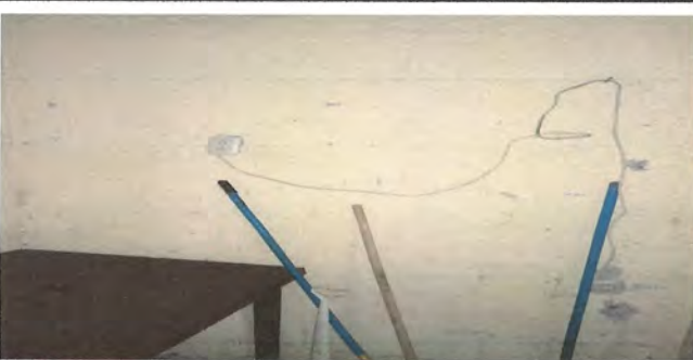
Foto 11: Sustrucción de luz eléctrica de tienda, plafoneras y tomacorrientes, bombillas y cableado
