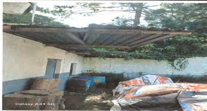
Foto1: Sustrucción de lámina, por lámina troquelada aluzinc calibre 26 mas Sustrucción de estructura portante de madera por metal
