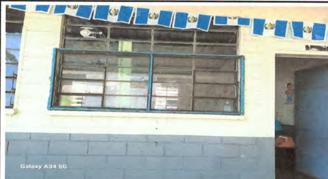
Foto 2: Fabricación de balcones de dos hojas corredizo de hierro en ventana
