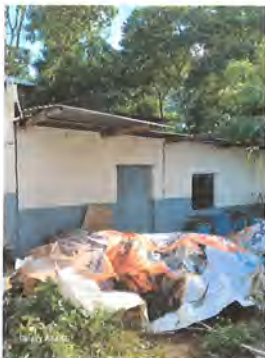
Foto 7: Mantenimiento a estructura de puerta (lijado, cambio de tubo , cepillado, sujeciones, aplicación de pintura)
