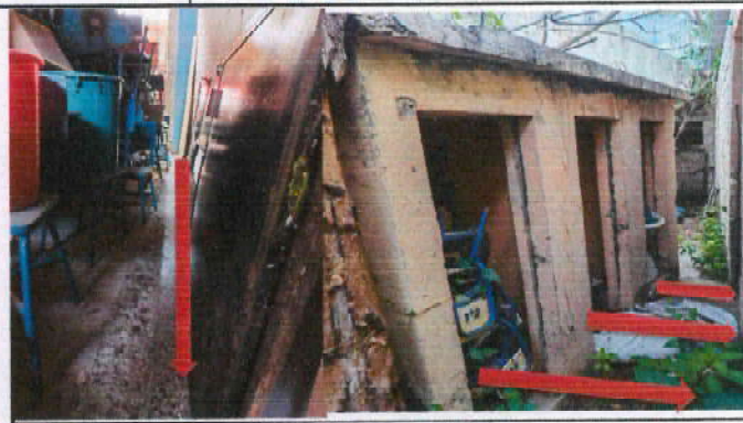
Foto 32: Instalación de tubería de 3/4 de agua potable para alimentar los lavamanos y lugar para habilitar inodoros que se encuentran en la parte de atrás de una aula, instalación accesorios, llaves de paso, contra llaves, y chorros. Se hará un circuito del cuál se sacará de la tubería existente. Incluye materiales y mano de obra.
