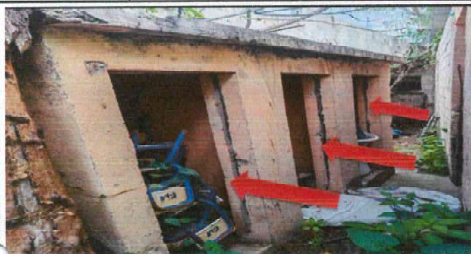
Foto 37: Fabricación e instalación de puertas metálicas de 0.60x1.50 con pasador para uso de los servicios sanitarios. Incluye armado, materiales e instalación.
