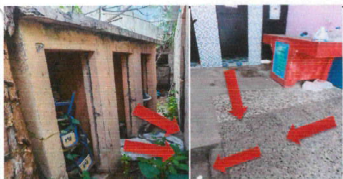
Foto 23: Instalación de Drenajes de aguas negras para el área de lavamanos y sanitarios que se encuentran en la parte de atrás de una aula, se hará con tubería de 4 Pulgadas y accesorios necesarios para llegar a la caja principal que se encuentra en el corredor frente a los servicios sanitarios existentes, para este trabajo hay que romper la torta y darle una pendiente adecuada para que se descarguen los desechos. Incluye materiales limpieza del área y mano de obra
