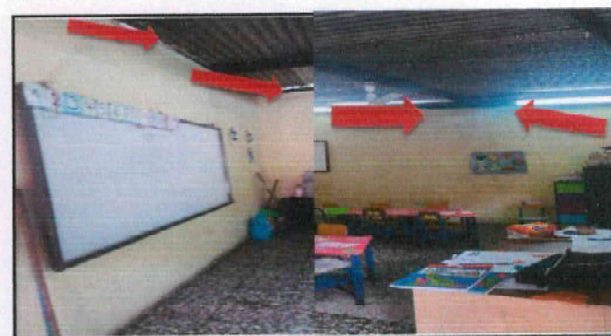
Foto 36: Refuerzo para estructura portante en aulas en todo el perímetro de la 03 aulas y así mejorar la resistencia y la estabilidad de la estructura metálica que sostiene el techo de las aulas
