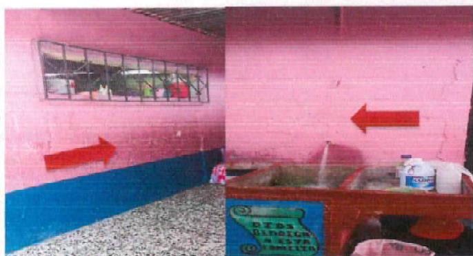
Foto 21: Suministro y aplicación de pintura lavable, color similar al existente, en paredes internas de la escuela, áreas de corredores, área en donde se trabajó la madura de corona, en el perímetro de la escuela. Incluye materiales y mano de obra.
