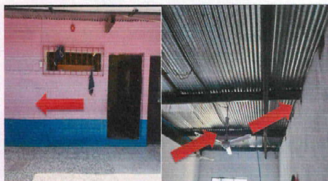
Foto 22: Suministro y aplicación de pintura lavable, color similar al existente, en paredes internas de la escuela, áreas de corredores, área en donde se trabajó la madura de corona, en el perímetro de la escuela. Incluye materiales y mano de obra.
