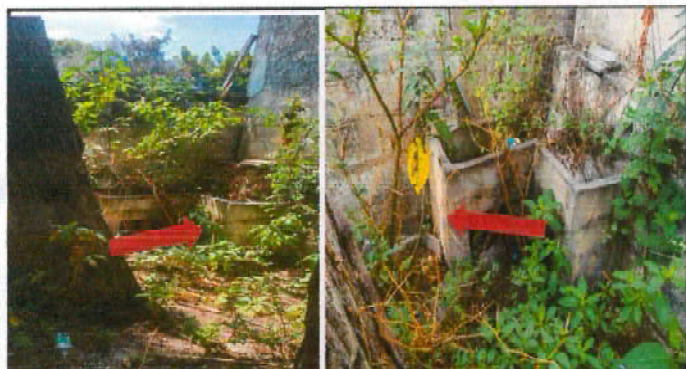
Foto 27: Instalación de azulejo similar a los existentes en el área de lavamanos que se encuentran en la parte de atrás de una aula, se forrarán por completo cada área en donde estarán los lavamanos, la base del lavamanos tendrá un azulejo diferente en color gris oscuro o similar Incluye materiales pegamento y mano de obra.
