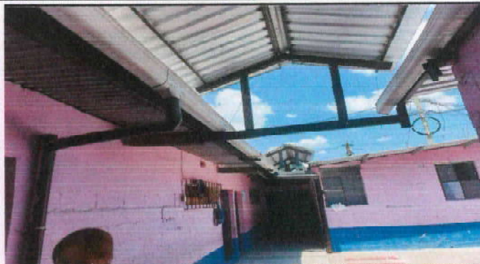
Foto:08 Armado de techo en corredor, armado de estructura de metal con costanera de 3x2, esta tendrá una aplicación de pintura anticorrosiva y una mano de pintura de aceite color negro. El armado será a dos aguas para cubrir el resto del corredor frente a las aulas, la lámina será en color gris Max Alum calibre 26. Incluye materiales y mano de obra.
