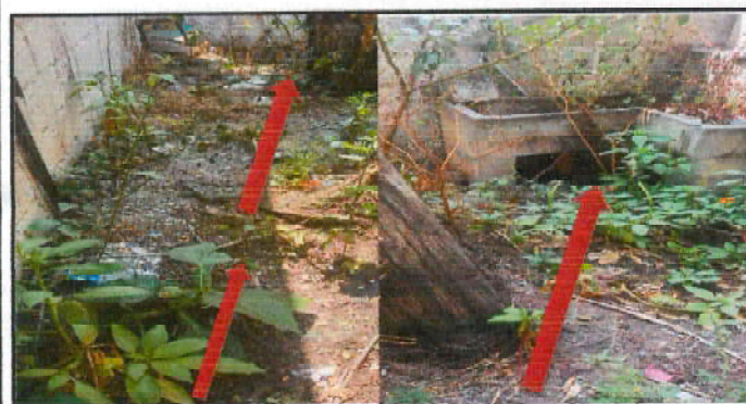
Foto 33: Fundición de caminamiento de concreto armado, se hará una banqueta para llegar al área de lavamanos de 0.50 de ancho x 0.10 m de grosor, incluye materiales y mano de obra
