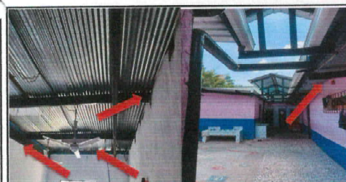
Foto 35: Refuerzo para estructura portante en aulas en todo el perímetro de la 03 aulas y así mejorar la resistencia y la estabilidad de la estructura metálica que sostiene el techo de las aulas
