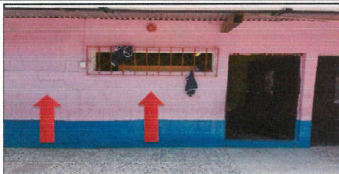
Foto 19: Instalación de ventanas de PVC S60 en color blanco, con vidrio claro de 5 mm, la ventana será corridiza con cedazo para que se tenga ventilación en los ambientes internos de 3 aulas. Las ventanas estarán sellada con silicón blanco. Incluye materiales y mano de obra
