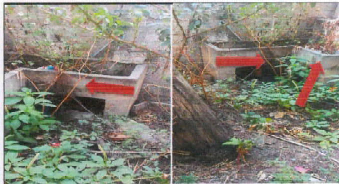
Foto 28: Instalación de azulejo similar a los existentes en el área de lavamanos que se encuentran en la parte de atrás de una aula, se forrarán por completo cada área en donde estarán los lavamanos, la base del lavamanos tendrá un azulejo diferente en color gris oscuro o similar Incluye materiales pegamento y mano de obra.
