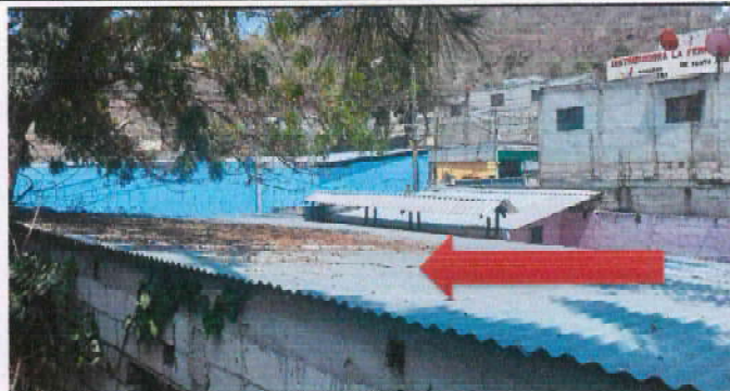
Foto 2: Desmontaje de lámina ondulada y canal de PVC blanco existente en el frente del área de aulas, incluye materiales y mano de obra.
