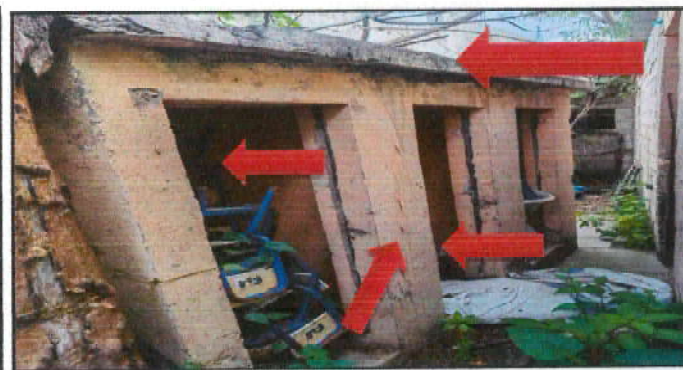
Foto 11: Recane de cielo y los servicios sanitarios, en donde es necesario la aplicación de repello y cernido en interior y exterior se hará una pendiente para dirigir del agua hacia la bajada y evitar que se humedezca y se empoce el agua, incluye materiales y mano de obra.
