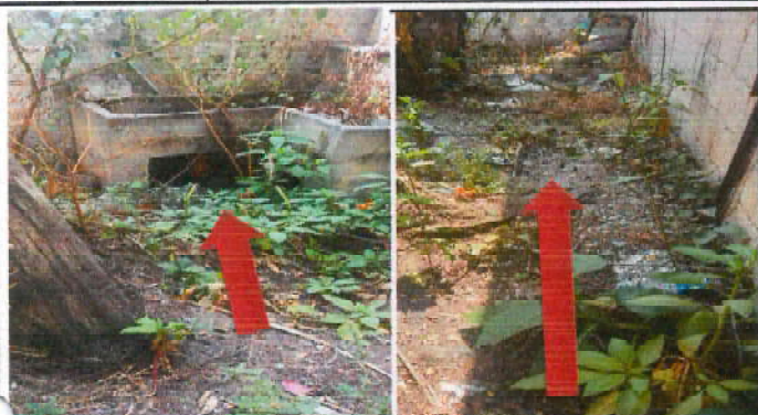
Foto 31: Instalación de tubería de 3/4 de agua potable para alimentar los lavamanos y lugar para habilitar inodoros que se encuentran en la parte de atrás de una aula, instalación accesorios, llaves de paso, contra llaves, y chorros. Se hará un circuito del cuál se sacará de la tubería existente. Incluye materiales y mano de obra.
