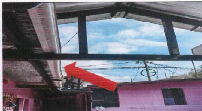
Foto 10: suministro e instalación de canal metálico con lámina Max alum calibre 26 de 0.10 x 0.15x 0.15 incluye suministro e instalación de pescantes de tee de hierro a cada 2.50 metros de distancia anclado a la estructura existente en las aulas, fabricación de boca tubos para hacer las conexiones de agua pluvial, fabricación de topes en los extremos de la misma lámina que se fabricaron los canales. Todas las uniones de lámina, boca tubos y topes se sellarán con Sika Flex gris, los trabajos incluyen materiales y mano de obra.
