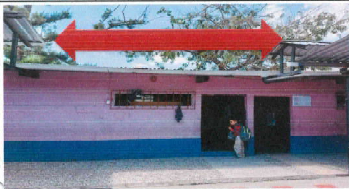
Foto:07 Armado de techo en corredor, armado de estructura de metal con costanera de 3x2, esta tendrá una aplicación de pintura anticorrosiva y una mano de pintura de aceite color negro. El armado será a dos aguas para cubrir el resto del corredor frente a las aulas, la lámina será en color gris Max Alum calibre 26. Incluye materiales y mano de obra.
