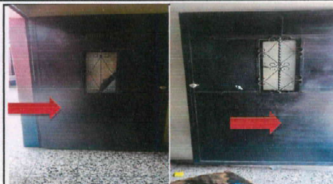
Foto 14: Remozamiento de puertas de aulas existentes, incluye desmontaje, nivelación, aplicación de pintura similar a la pintura existente de la puerta, incluye materiales y mano de obra.
