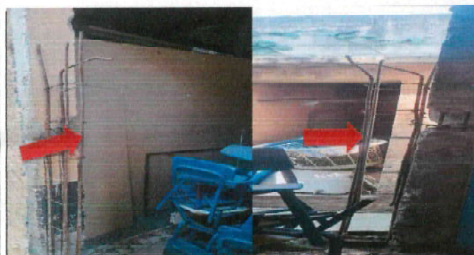
Foto 15: Instalación de puerta de metal existente en área de pasillo que comunica a los servicios sanitarios nuevos (el trabajo será de remozamiento de puerta, lijado, aplicación de anticorrosivo, pintura de aceite como acabado final). Materiales y mano de obra incluida.
