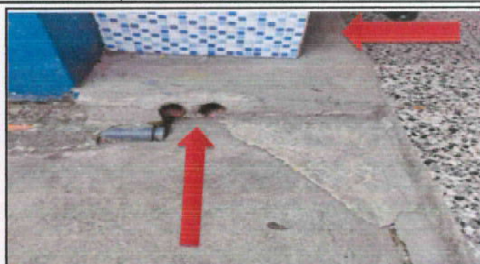
Foto 26: Elaboración de caja de registro de cortina en donde se habilitarán los nuevos servicios de la escuela.
