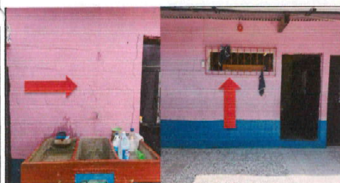
Foto 17: Romper pared para crear vano para ventanas de 03 aulas en un área de 1.50 de ancho x 1.00 de altura para dejar un dintel de 1.20 metros. Se resanará y tallará el área para dejar el vano listo para instalar ventana de PVC. Incluye materiales y mano de obra.
