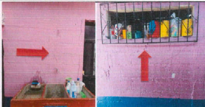
Foto 20: Instalación de ventanas de PVC S60 en color blanco, con vidrio claro de 5 mm, la ventana será corridiza con cedazo para que se tenga ventilación en los ambientes internos de 3 aulas. Las ventanas estarán sellada con silicón blanco. Incluye materiales y mano de obra
