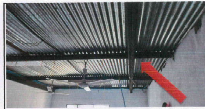
Foto 6: Remozamiento de estructura existente, lijado de la superficie de la costanera y aplicación de anticorrosivo con pintura de aceite en color negro. Incluye materiales y mano de obra.
