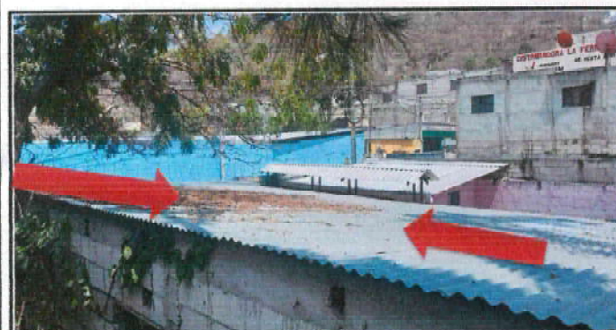
Foto 39: Instalación de lámina troquelada Max Alum calibre 26 en color similar a la existente, sujeta con tornillos pulser de 2.5 pulgadas incluye materiales y mano de obra.
