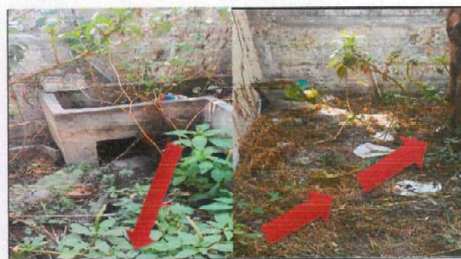
Foto 34: Fundición de caminamiento de concreto armado, se hará una banqueta para llegar al área de lavamanos de 0.50 de ancho x 0.10 m de grosor, incluye materiales y mano de obra
