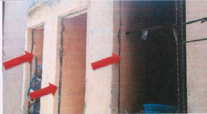
Foto 38: Fabricación e instalación de puertas metálicas de 0.60x1.50 con pasador para uso de los servicios sanitarios. Incluye armado, materiales e instalación.
