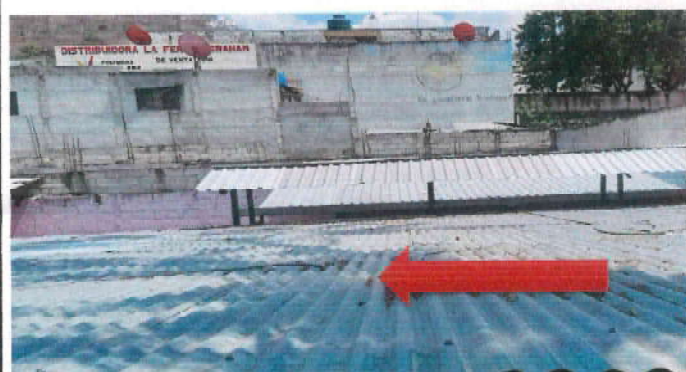
Foto 3: Desmontaje de lámina ondulada y canal de PVC blanco existente en el frente del área de aulas, incluye materiales y mano de obra
