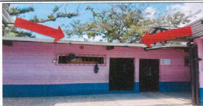
Foto 1: Desmontaje de lámina ondulada y canal de PVC blanco existente en el frente del área de aulas, incluye materiales y mano de obra.
