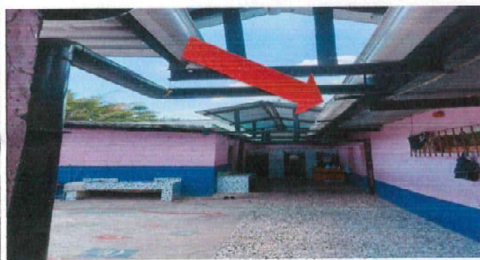
Foto:09 Suministro e instalación de canal metálico con lámina Max alum calibre 26 de 0.10 x 0.15x 0.15 incluye suministro e instalación de pescantes de tee de hierro a cada 2.50 metros de distancia anclado a la estructura existente en las aulas, fabricación de boca tubos para hacer las conexiones de agua pluvial, fabricación de topes en los extremos de la misma lámina que se fabricaron los canales. Todas las uniones de lámina, boca tubos y topes se sellarán con Sika Flex gris, los trabajos incluyen materiales y mano de obra.
