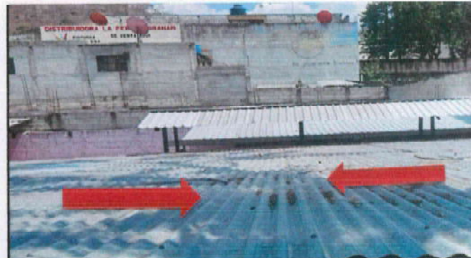
Foto 40: Instalación de lámina troquelada Max Alum calibre 26 en color similar a la existente, sujeta con tornillos pulser de 2.5 pulgadas incluye materiales y mano de obra.
