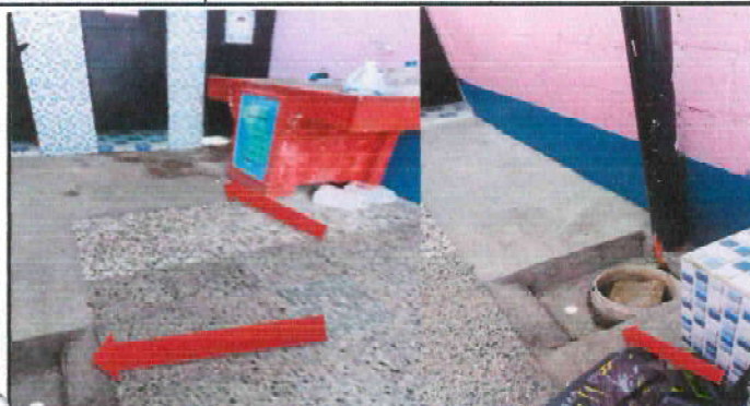
Foto 25: Elaboración de caja de registro de cortina en donde se habilitarán los nuevos servicios de la escuela.
