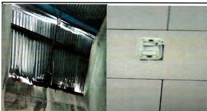
Foto 7: Sustitución de lamparas led / sustitución de interruptores
