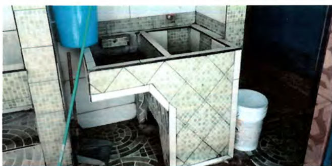
Foto 10: Sustitución de pila por lavamanos para baños
