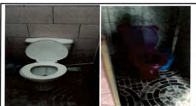
Foto 6: sustitucion de 6 inodoros
