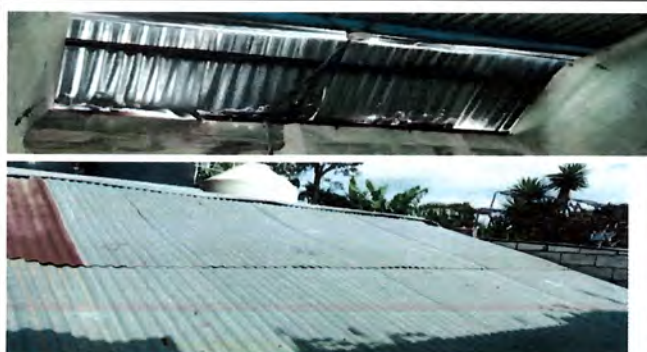
Foto 2: sustitucion de lamina existente por lamina troquelada aluzinc calibre 26 en area de baños de niños y niñas / sustitucion de capote metalico aluzinc en union de techo de dos aguas area de baños.
