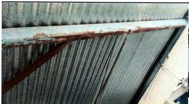
Foto 3: mantenimiento de estructura de techo en area de baños niños y niñas incluye limpieza lijado cambio de partes dañadas y aplicación de pintura anticorrosiva.
