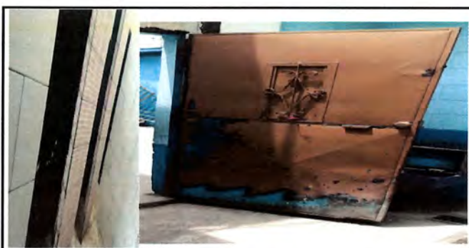
Foto 4: mantenimiento de 8 puertas de metal y sustitucion de 2 puertas 1 con chapa y la otra con pasadores
