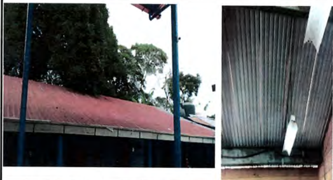
Foto1: sustitucion de lamina por lamina troquelada aluzinc calibre 26 en aulas 1roA, 1roB, 1roC
