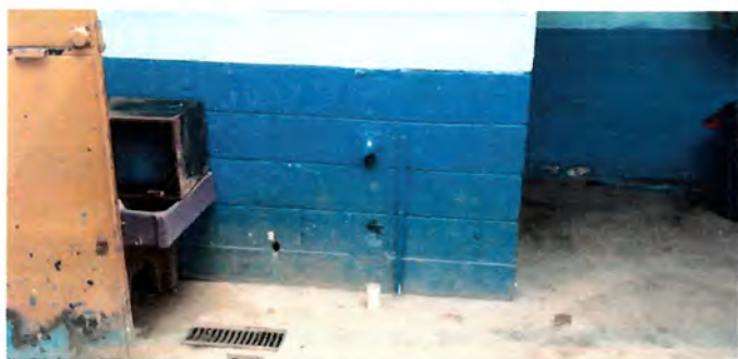
Foto 9: Suministro e instalacion de estructura con techo para cubrir el área de la pila
