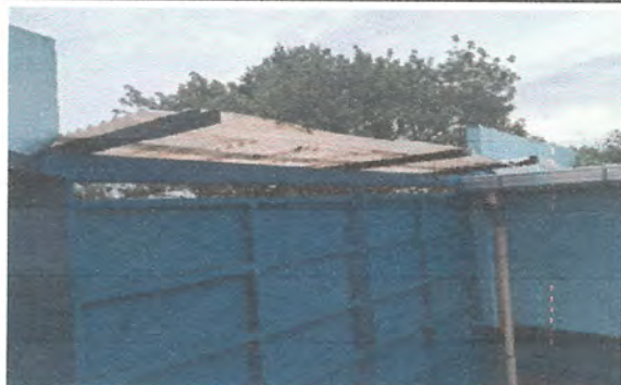
2.3 Sustitución de estructura de soporte de metal, por metal Sustitución de estructura portante de metal con soldadura eléctrica con tubos cuadrados de 2"2 pulgadas chapa 16, soportadas con soldadura eléctrica a estructuras, incluye aplicación de pintura color azul institucional. Área de portón entrada principal.
