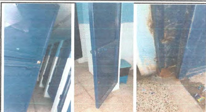
10.1 Mantenimiento a estructura (lijado, cambio de tubo, cepillado, sujeciones, aplicación de pintura) a puertas servicios sanitarios. Mantenimiento a puertas de metal, incluye lijado, cepillado, lubricación y aplicación de 2 capas de pintura anticorrosiva color azul institucional de secado rápido.
