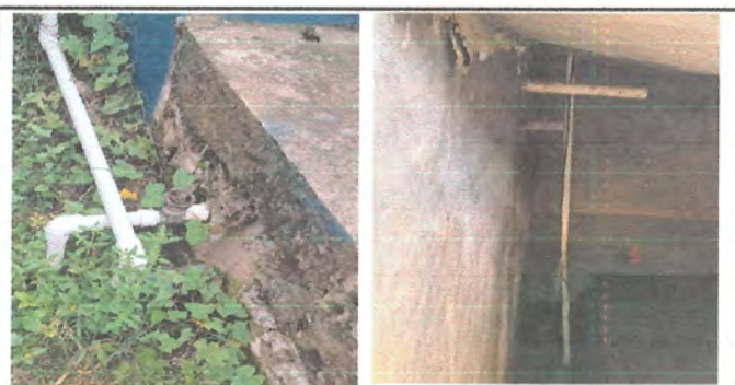
18.5 Sustitución de accesorios depósito de agua Sustitución de accesorios de depósito de agua incluye válvula flote de cisterna de 1 pulgada, válvula de pie de 1 pulgada instalaciones se realizaron con teflón y pegamento marca Tangit Cisterna de agua.
