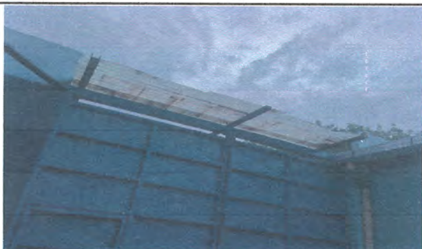
1.2 Sustitución de capote de lámina para lámina troquelada Sustitución de capote para lámina troquelada en techo con tornillos tipo pulser de 5/16 x 2 pulgadas de largo y aplicación de sikflex en uniones y tornillos. Área de techo de portón entrada principal.
