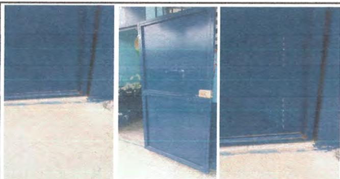
4.1 Mantenimiento a estructura (lijado, cambio de tubo, cepillado, sujeciones, aplicación de pintura). Mantenimiento a puertas de metal, incluye lijado, cepillado, lubricación y aplicación de pintura anticorrosiva color azul institucional de secado rápido. Puertas de salones de clase.
