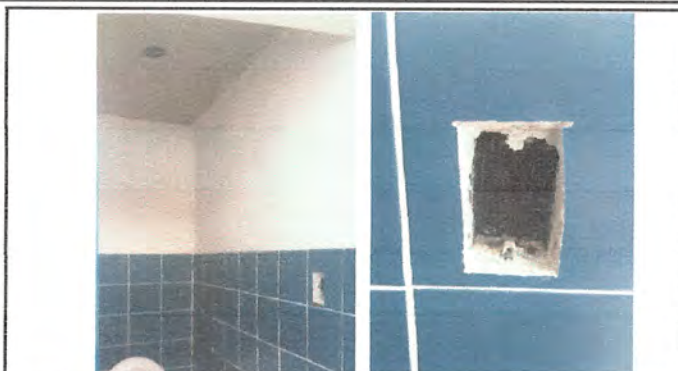
19.11 Instalación de unidades luz Sustitución de interruptores simples y accesorio de fijación. Area sanitarios de niñas y maestros.
