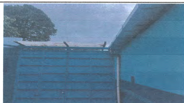
1.4 Sustitución de bajada de agua pluvial de PVC por tubo PVC 3 Sustitución e instalación de bajadas de agua pluvial de PVC por tubería de PVC de 3 pulgadas (Incluye tubería de PVC de 3 y 2 pulgadas con sus respectivos accesorios, (uniones codos a 45 grados, codos a 90 grados, abrasaderas de hierro plano de 1/2 pulgada por 1/8 de pulgada, tarugos expansibles y tornillería). Aplicación de pintura de aceite de secado rápido color azul institucional).
