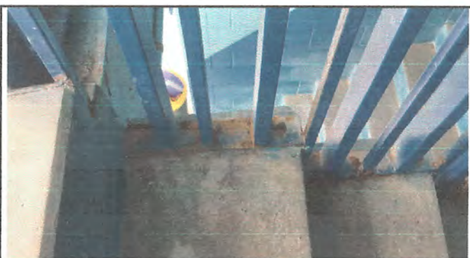
11.1 Mantenimiento a barandas de metal Mantenimiento a barandas de metal, incluye lijado, cepillado y aplicación de pintura anticorrosiva color azul institucional de secado rápido. Área de aulas y pasillos de primero y segundo nivel.
