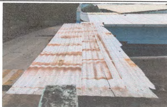
1.1 Sustitución de lámina, por lámina troquelada aluzinc calibre 26 Sustitución de lámina troquelada E25 ALUZINC calibre 26 con tornillos tipo pulser de 5/16 x 2 pulgadas de largo y aplicación de sikflex en tornillos. Área de portón entrada principal.
