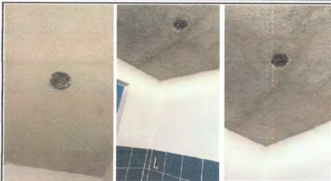
19.11 Instalación de unidades luz Sustitución de plafoneras con foco led de 12 watts, cable calibre 12, tubería y accesorios en pvc de 3/4 y accesorios de fijación. Area sanitarios de niñas y maestros.
