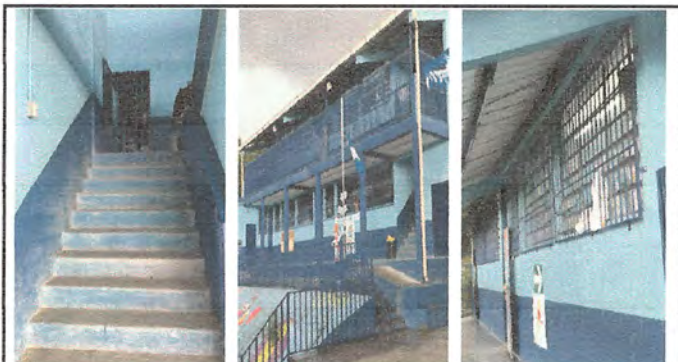
9.1 Pintura en muros exteriores e interiores Suministro y aplicación de pintura latex de exteriores e interiores con colores institucionales indicados. Aulas, dirección JV, baños y pasillos.
