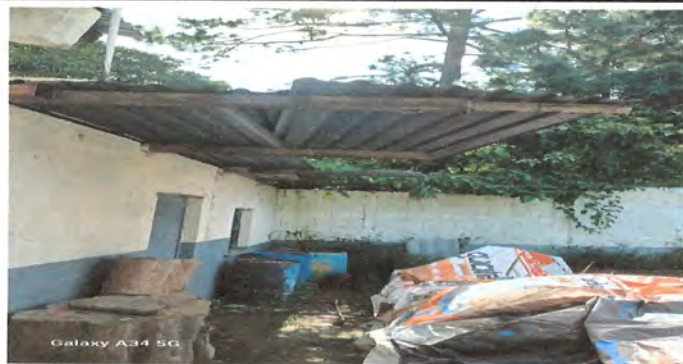
Foto1: Sustrucción de lámina, por lámina troquelada aluzinc calibre 26 mas Sustrucción de estructura portante de madera por metal
