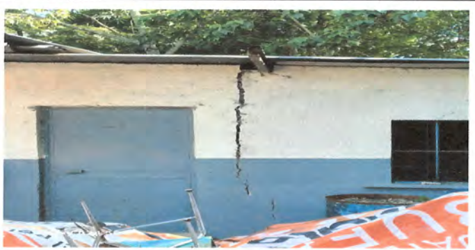
Foto 3: Reparación de muro perimetral de block en área de aula que presenta daños
