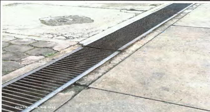
Foto 4: Sustrucción Fabricación e instalación de rejas en Área de Patio
