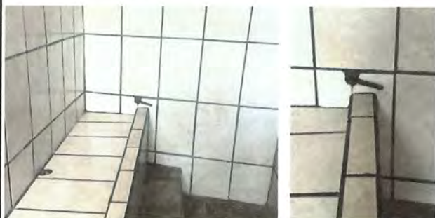
Foto 9: Sustitución de llave de mingitorio
