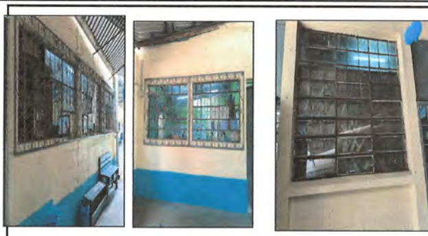
Foto 2: Sustitucion de estructura de metal de ventana, por aluminio tipo corredizas 2do. A, 6to y Dirección
