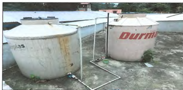
Foto 5: Sustitución de accesorios deposito de agua.
