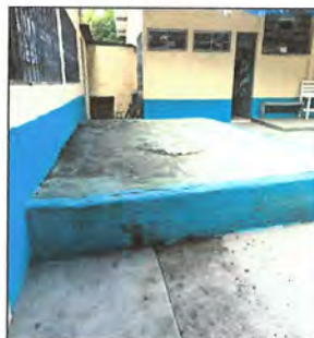
Foto 8: Materiales y mano de obra de: Limpieza de pared, ensavietado, emparejado de pared con monocapa gris y cernido blanco con monocapa fino, para area de escenario.
