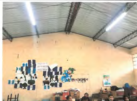
Foto 10: Instalación de unidades de fuerza (tomacorrientes), incluye cableado htm #12 y ducto sobre puesto de 1/2"
