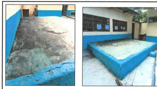
Foto 4: Reparacion de concreto de patio. metros de piso para exterior, impermeabilización del mismo, incluye: nivelacion del area + fabricacion de 2 gradas. Escenario.
