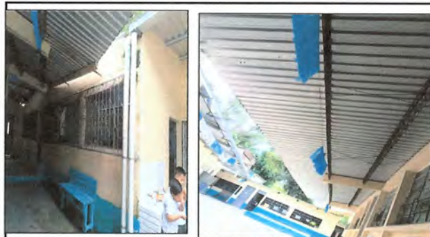
Foto 3: instalacion de canal, incluye soporteria y fijaciones + 3 bajadas con tubo pvc , es necesario hacer estructura metalica para fijacion de canales en el area de 3ro, 4to y 1ro .
