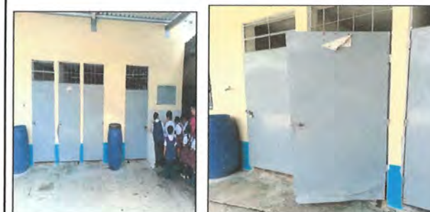
Foto 6: Materiales y mano de obra de: Fabricación e instalación de puertas de metal en area de baños, no incluyen chapas, solo pasadores de metal.
