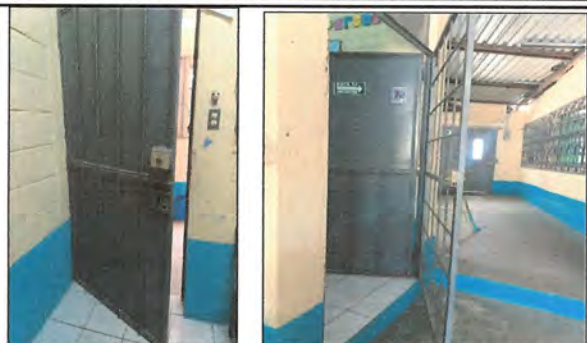
Foto 1: "Mantenimiento a estructura, Lijado, cambio de tubo, cepillado, aplicación de pintura). Reparación de puerta principal y reja incluye chapas, sustitución de metal en mal estado, desmontaje e instalacion + 2 manos de pintura Dirección."
