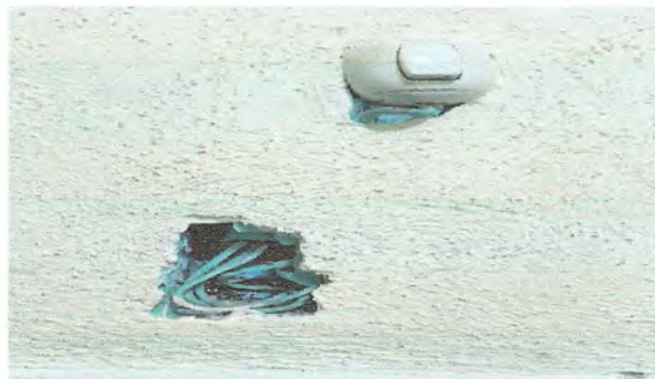
Foto 1: Sustitución de 2 swich sencillo y 3 tomacorrientes 120 voltios, entubado cableado y emplacado, 1 ubicado en servicio sanitario de maestros y 2 en salón de clases de párvulos.
