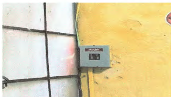
Foto 6: Sustitución de 2 tableros de 8 polos con sus respectivos flipones, ubicados en servicio sanitario de maestros y oficina de cómputo
