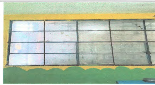
Foto 6: Sustitución de estructura de metal de ventanas y sustitución de vidrios de 5 mm
