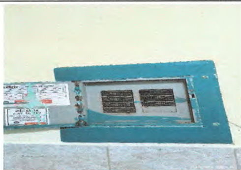
Foto 5: Sustitución de 2 tableros de 8 polos con sus respectivos flipones, ubicados en servicio sanitario de maestros y oficina de cómputo
