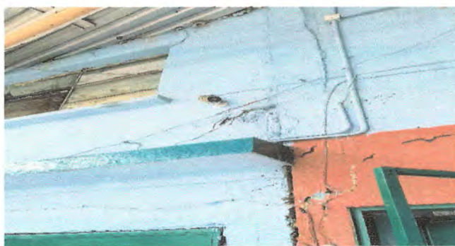
Foto 3: Sustitución de acometida de 78 metros, cableado con 2 #6 +2#8 thhn, entubado con tubo pvc de 1" con sus respectivos accesorios alrededor de módulo de entrada, servicio sanitario de maestros y oficina
