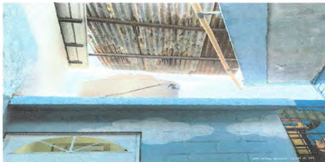
Foto 1: Sustitución de lámina por lámina troquelada aluzinc calibre 26 y sustitución de soporte de metal por metal de 3.20 m x 7 m en patio frente alula de párvulos.
