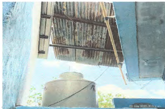
Foto 2: Sustitución de lámina por lámina troquelada aluzinc calibre 26 y sustitución de soporte de metal por metal de 3.20 m x 7 m en patio frente alula de párvulos.
