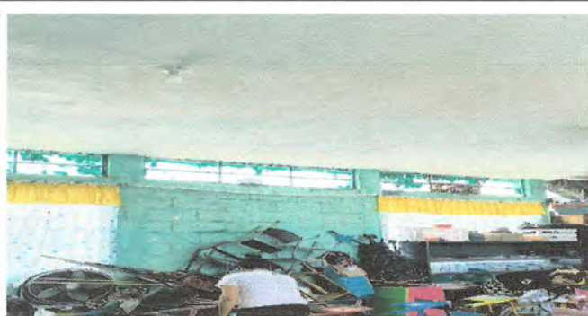
Foto 3: Sustitución de lámparas a prueba de polvo y humedad de 2 x 18 watts tipo led. Instaladas en salón de clases de párvulos 1 una instalada en el salón de clases de 2do. "B"
