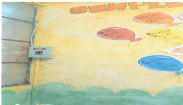
Foto1: Aplicación de cernido en pared en salón de cómputo
