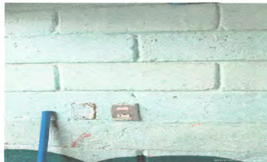
Foto 2: Sustitución de 2 swich sencillo y 3 tomacorrientes 120 voltios, entubado cableado y emplacado, 1 ubicado en servicio sanitario de maestros y 2 en salón de clases de párvulos.
