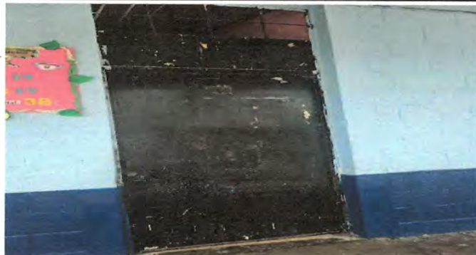
Foto1: sustitución de puertas de metal
