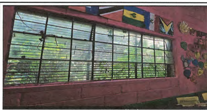
Foto 4: Cerramiento de ventanas
