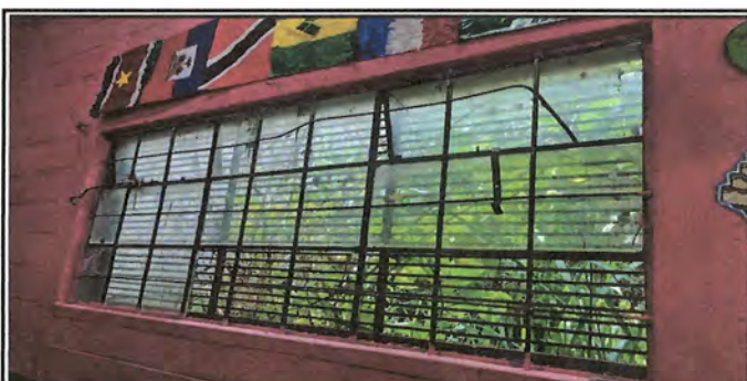
Foto 6: Repello y cernido, al sellar las ventanas
