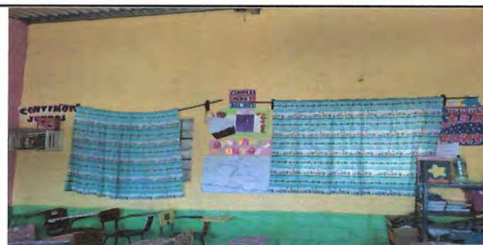
Foto 5: Pintura de muro interno
