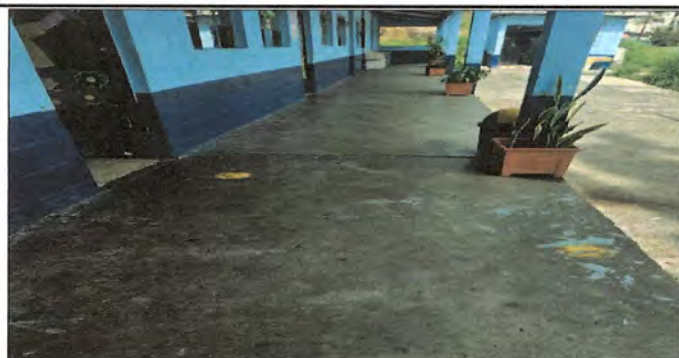
Foto 3: Sustitución de piso ceramico en corredor
