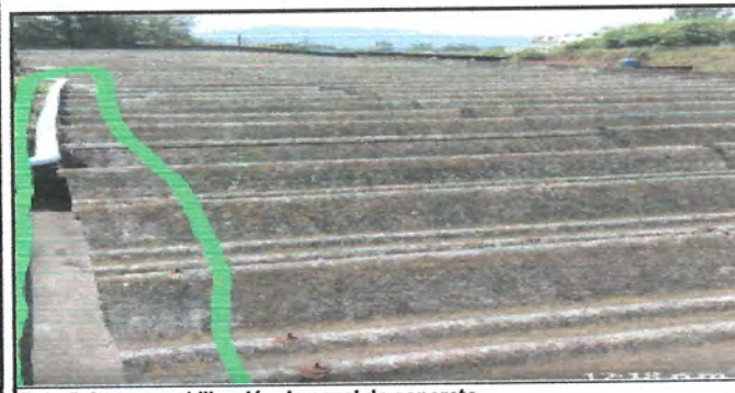
Foto 5: Impermeabilización de canal de concreto
