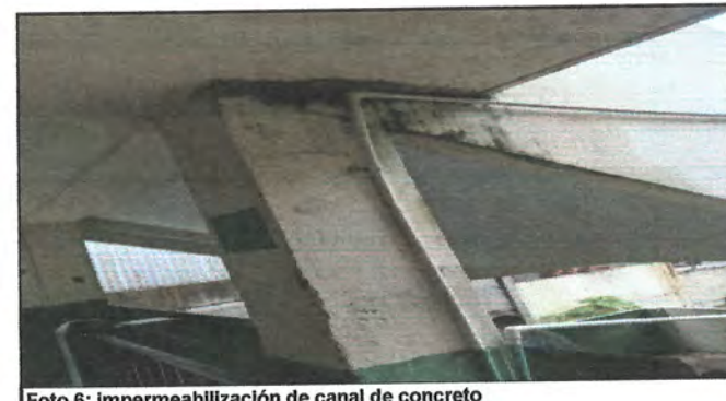
Foto 6: Impermeabilización de canal de concreto
