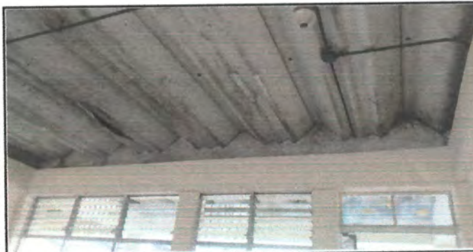
Foto 3: Suministro e instalación de estructura de soporte de metal
