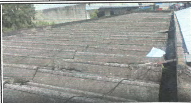
Foto1: Sustrucción de lámina de duralita por lámina troquelada calibre 26
