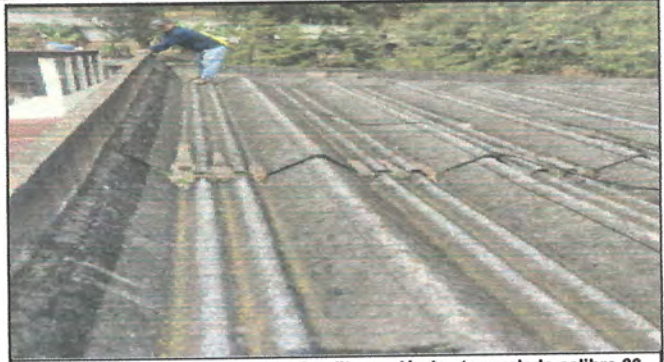
Foto 2: Sustrucción de lámina de duralita por lámina troquelada calibre 26
