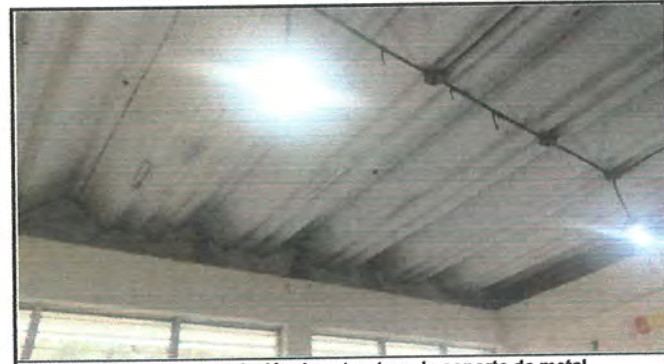
Foto 4: Suministro e instalación de estructura de soporte de metal
