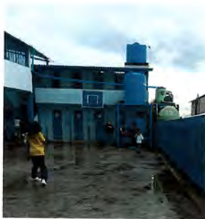
Foto 9: Pintura en muros exteriores e interiores
