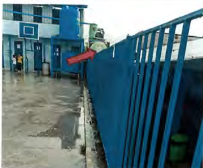
Foto 15: Readecuación de tinaco en nueva area incluye tubería para suministro y descarga
