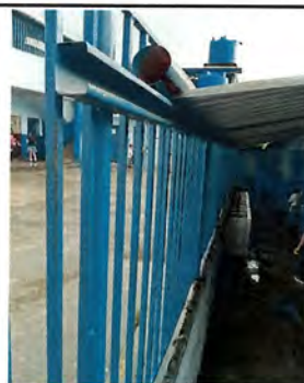
Foto 6: Suministro e instalación de canal de alto caudal de PVC con sus respectivos pescantes
