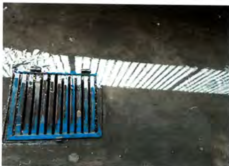
Foto 13: Mantenimiento a reposadera, destapado de tuberías y resanado de la misma
