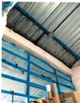
Foto 1: Reparación con Sikaflex de elementos de fijación de tornillos tipo L
