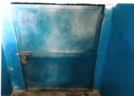
Foto 3: Reparación de puerta en bodega
