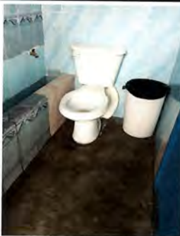
Foto 11: Sustitución de inodoro
