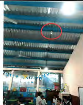
Foto 14: Sustitución de focos ahorrador 50W Led
