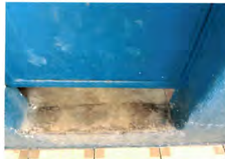
Foto 10: Reparación de puerta de metal en baños (agregado de 0.20m x 0.65m)
