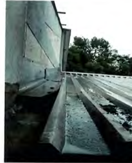
Foto 8: Suministro e instalación de botaguas de dirección
