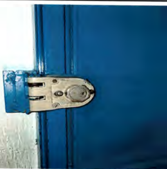
Foto 5: Cambio de chapa en porton principal
