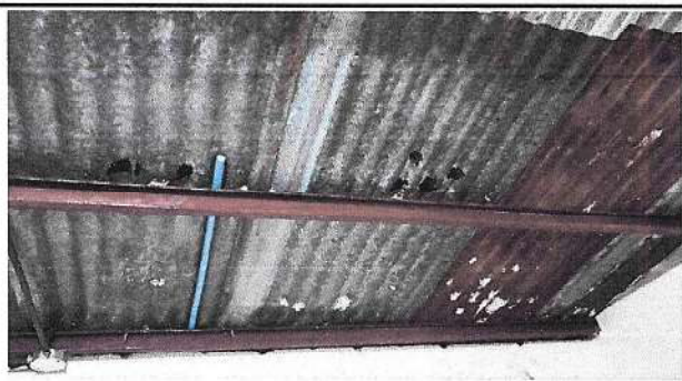
Foto1: Cubierta de bodega cambio de lamina y desnivel . Sustitucion de sistema electrico.
