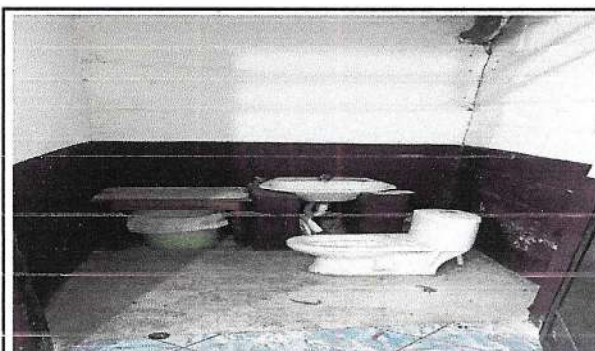
Foto 4: reubicacion de sanitarios de pre primaria.
