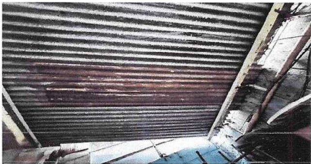
Foto 3: sustitucion de lamina vieja por lamina nueva refuerzo de galera patio trasero
