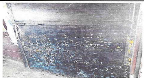
Foto 4: remozamiento para puertas de aulas.
