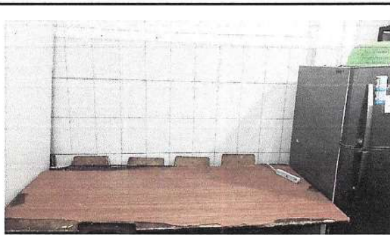
Foto 2: sustitucion de mesa por mesa fundida con azulejo
