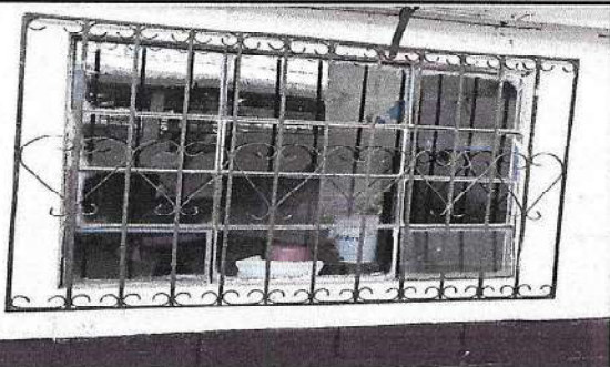
Foto1: sustitucion de ventana por ventana de PVC con mosquitero, remozamiento de balcon
