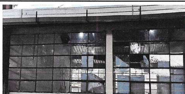
Foto 2: sustitucion de ventanas por ventanas corredizas en aulas.
